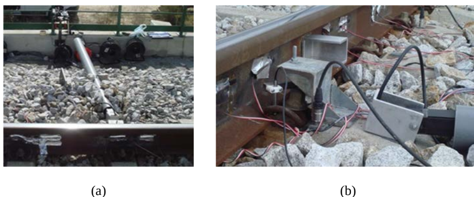
Figura 6.36 - Monitorização do deslocamento vertical de uma travessa localizada sobre a PH: (a) montagem do sistema de medição e (b) pormenor da instalação do sensor PSD na travessa
