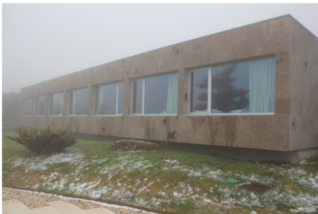
Figura 5.11 – Revestimento com ICB da fachada orientada a este do hotel Casa das Penhas Douradas
