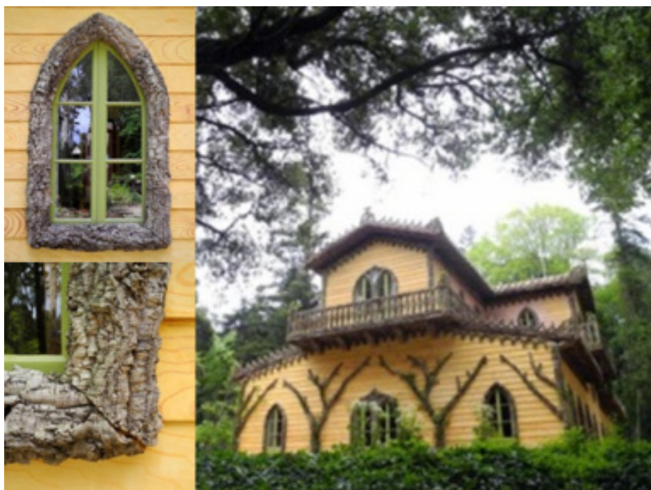
Figura 4.2 – Chalé da Condessa D'Edla após recuperação.
