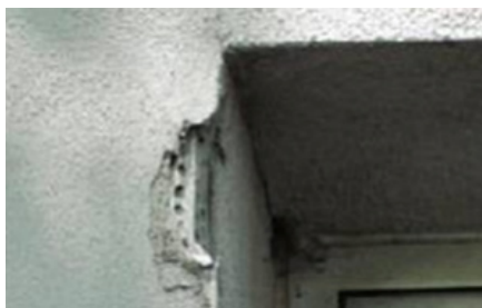
Figura 3.37 – Destacamento de acabamento.
