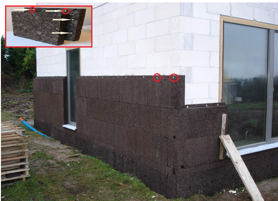
Figura 4.7 – Distribuição da fixação mecânica numa placa de ICB.
