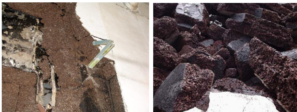
Figura 2.14 – Aglomerado negro resultante da demolição dos armazéns frigoríficos.
