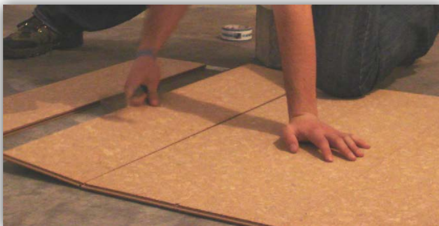
Fig. 3.1 – Facilidade de aplicação do pavimento flutuante tipo parquet , que foi objeto de estudo no presente trabalho, proporcionada pelo seu sistema de encaixe macho-fêmea
