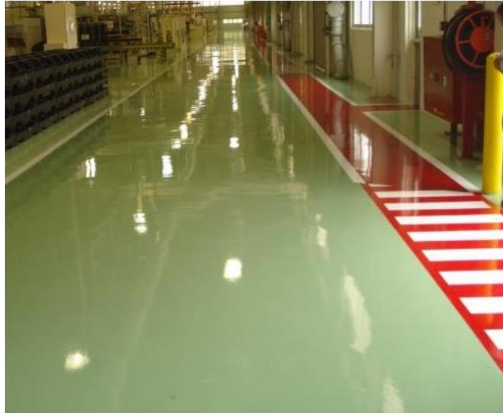
Figura 49 - Pavimento revestido (Imagem do Autor)
