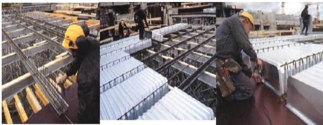
Fig. 3.28 – Aplicação de chapas de aço galvanizado [37]
