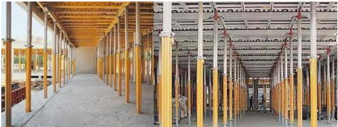
Figura 3.53 - Escoramento lajes de vigotas [41]
