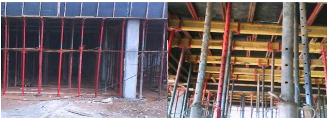
Fig. 3.37 - Escoramento metálico [43]
