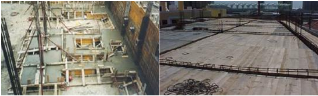
Fig. 3.4 – Aplicação dos sistemas de cofragens tradicionais em sapatas e lajes [8]
