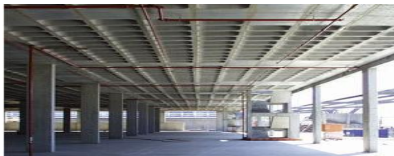
Fig. 2.3 – Laje fungiforme aligeirada com moldes recuperáveis [24]
