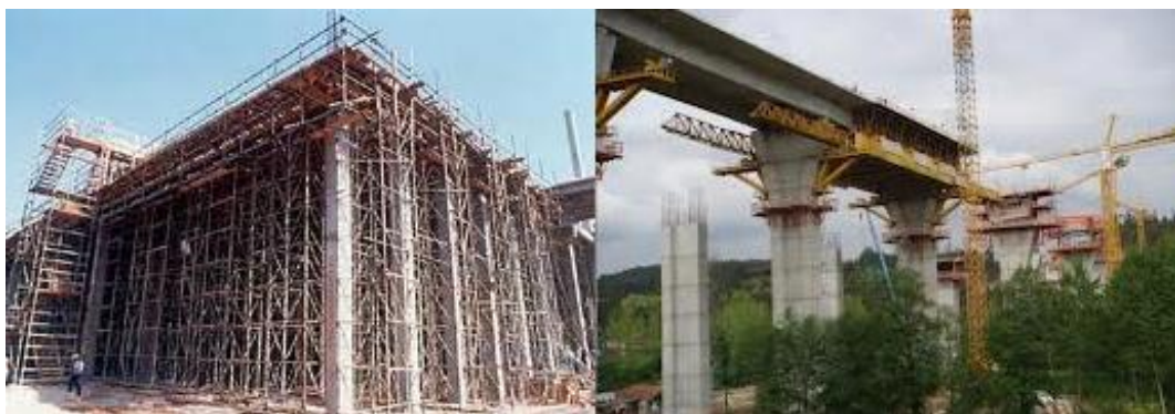
Fig 3.34 - Escoramento (cimbra ao solo) e viga de lançamento (cimbra aérea) [40]
