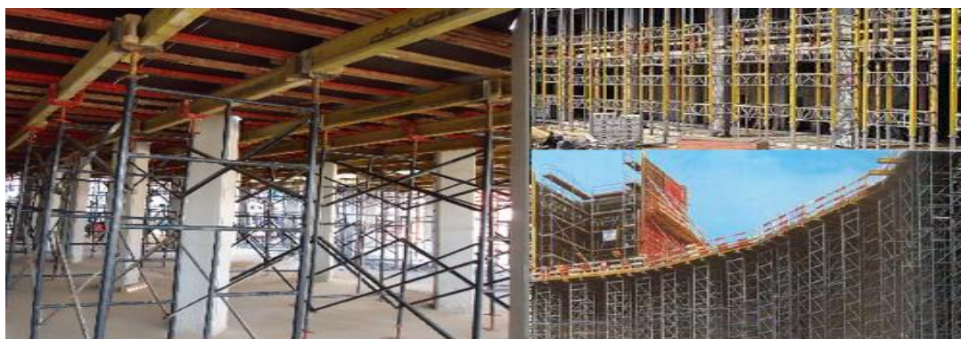
Fig. 3.39 - Torres metálicas tubulares [11]
