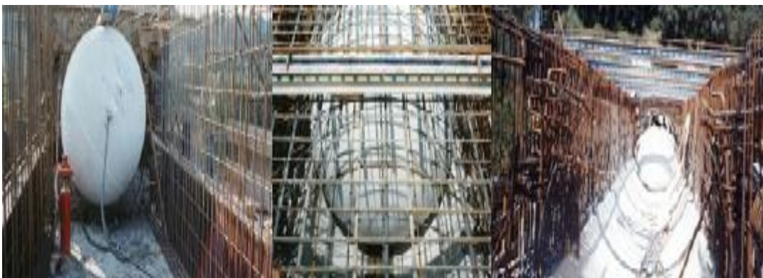
Fig. 3.27 – Cofragens pneumáticas [37]
