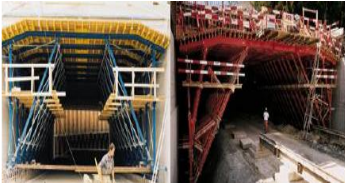
Fig. 3.24 – Sistema túnel – variante mesa [9]
