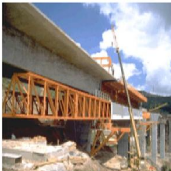
Fig. 3.25 – Vigas de lançamento [37]
