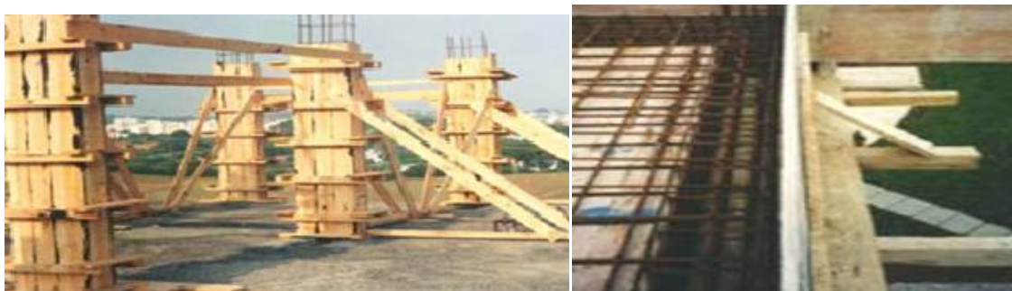
Fig. 3.5 – Aplicação dos sistemas de cofragens tradicionais em pilares e vigas [8]
