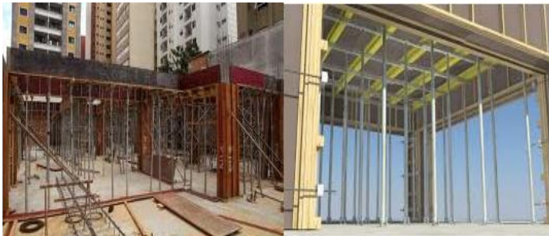
Fig. 3.41 - Escoramento tubular ajustável [11]
