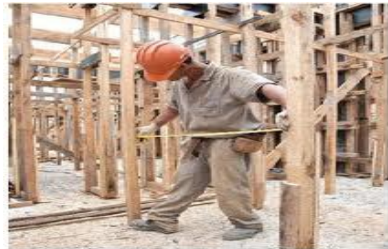
Fig. 3.36 - Operário a medir espaçamento entre prumos [43]
