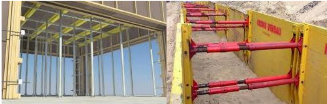
Fig. 3.32 - Escoramento e entivação/ orientação [21]
