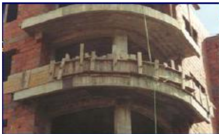
Fig. 3.2 – Aplicação dos sistemas de cofragens tradicionais numa varanda [7]
