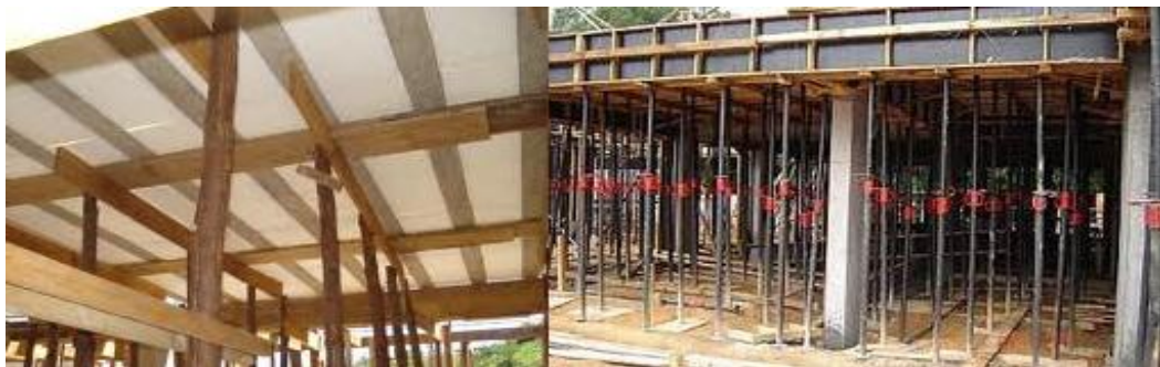
Fig. 3.33 - Escoramento em madeira e escoramento metálico [40]
