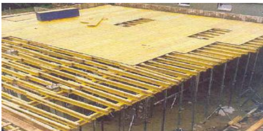
Fig. 3.13 – Sistemas racionais para execução de lajes [8]
