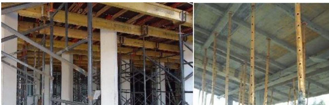
Fig. 3.55 – Escoramento de coberturas [42]
