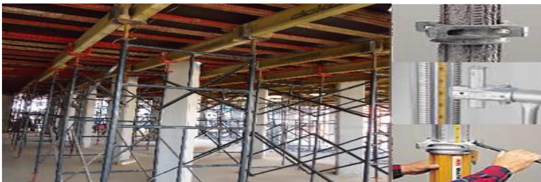
Fig. 3.38 - Prumo tubular com ajuste telescópico [43]
