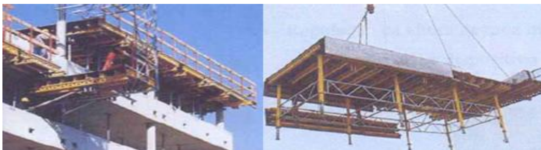
Fig. 3.21 – Sistema de mesa (e parede) [9]
