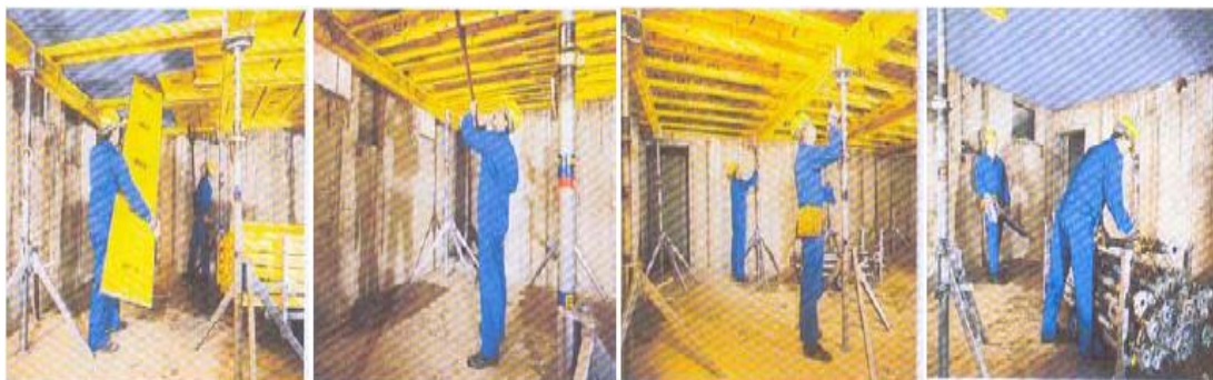
Fig. 3.17 – Desmontagem das cofragens de uma laje de cobertura [8]
