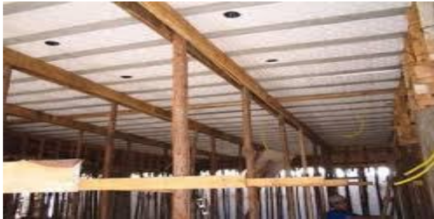
Fig. 3.35 - Escoramento em madeira [40]
