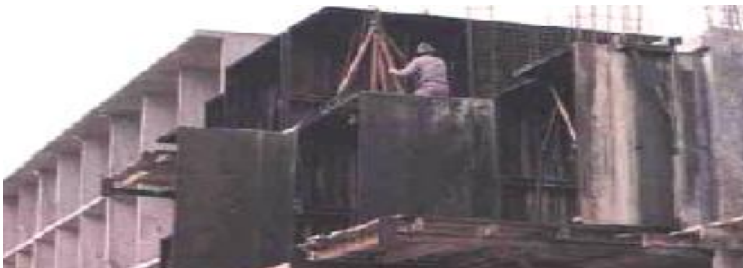
Fig. 3.22 – Sistema túnel [9]
