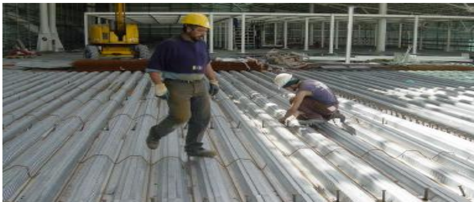
Fig. 3.29 – Fixação de chapas nos apoios [37]
