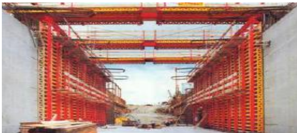
Fig. 3.23 – Sistema túnel – variante parede [9]
