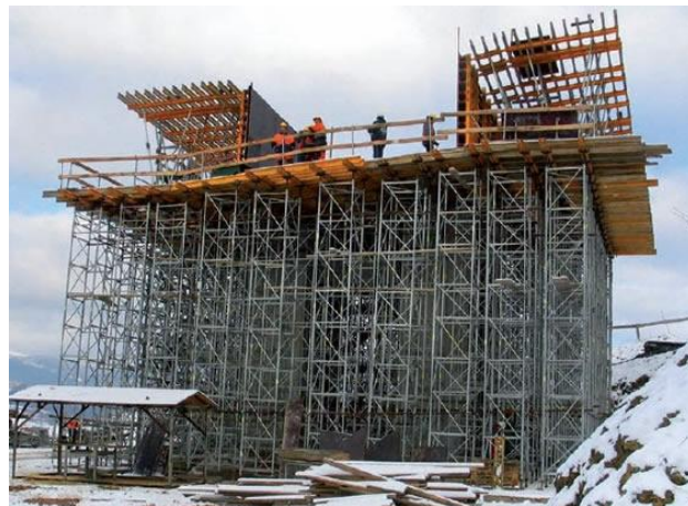
Fig. 3.10 – Prumos (cimbres para pés-direitos elevados) [9]
