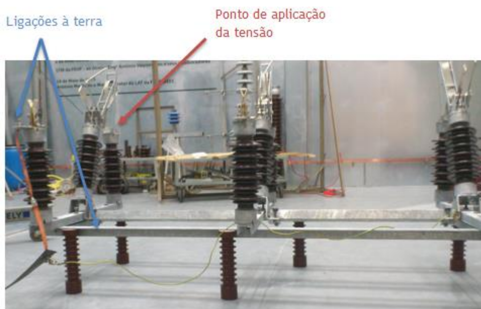
Figura 6.2 - Montagem para os ensaios de distância de isolamento
