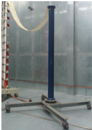
Figura 5.12 - Divisor de tensão do gerador de choque
