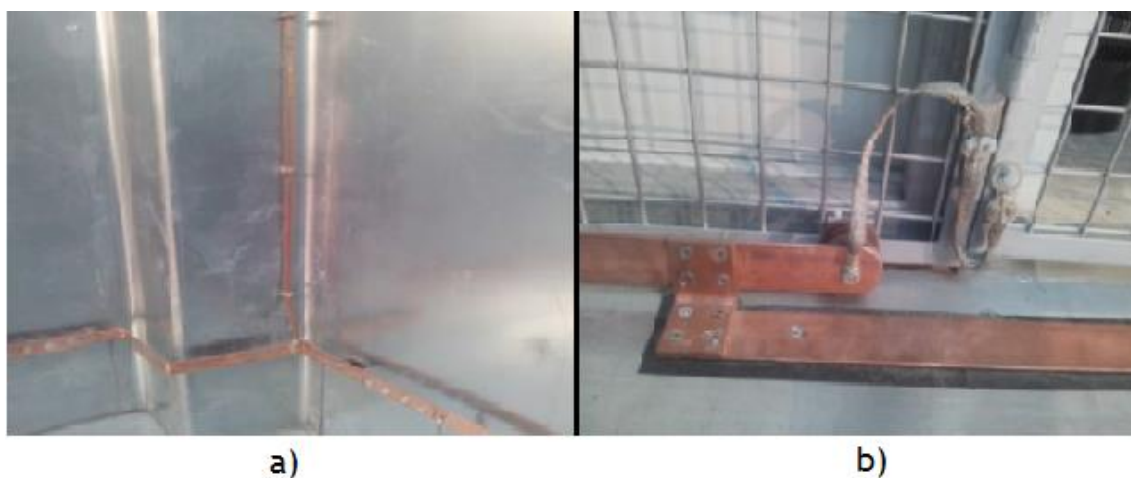
Figura 5.3 - Interligações ao barramento principal
