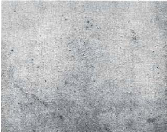
Figura 8 - Grau de corrosão Ri 1 [14].
