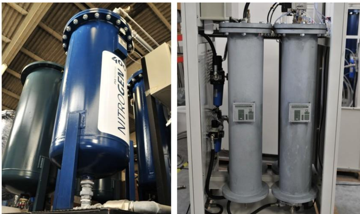
Figura 3 - Unidade PSA de produção de azoto de elevado débito (esquerda); PSA de débito médio (direita)
