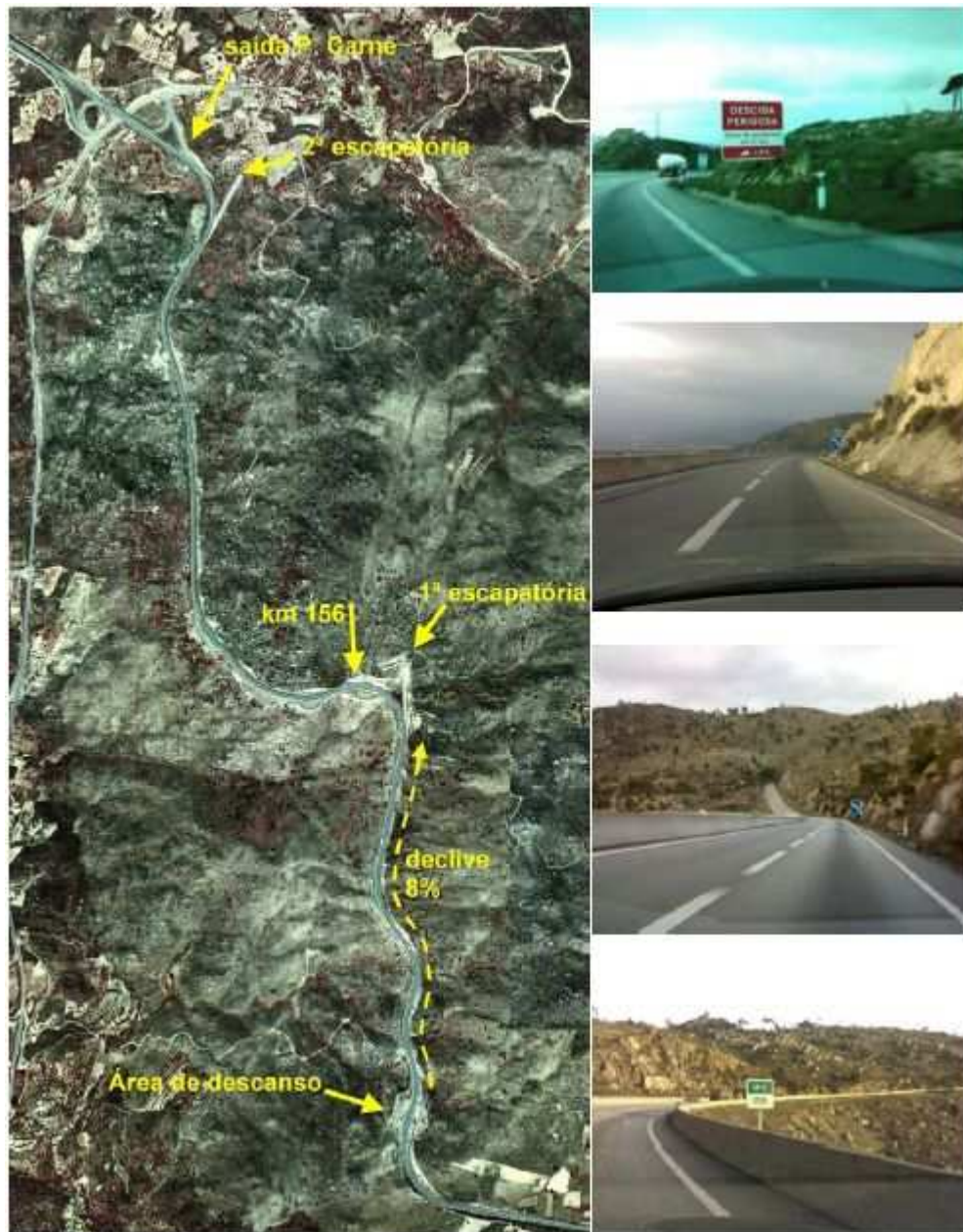
Figura 8 - Troço do IP5, descida entre Guarda e Porto da Carne.
