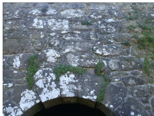
Figura 1.7 – Saída do túnel para a parte inferior do baluarte, lado norte
