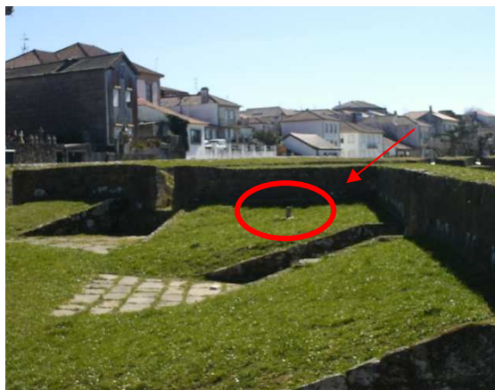
Figura 3.7 – Localização do inclinómetro I3, visto da posição do inclinómetro I2
