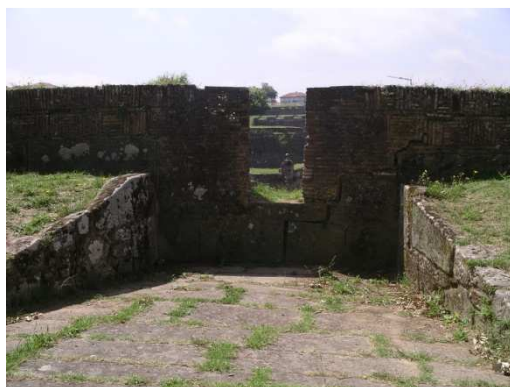
Figura 1.8 – Lado superior esquerdo do baluarte, lado sul
