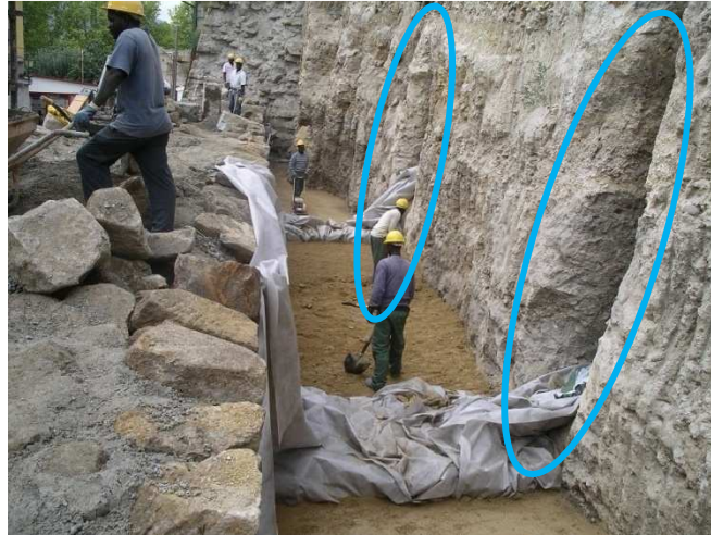
Figura 6.11 – Valas do sistema de drenagem da Muralha de Chaves
