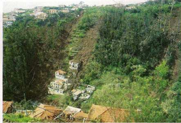
Figura 2.3 – Erosão e avalanche em Vasco Gil – Funchal, Fevereiro 2010 (Valente, 2010)
