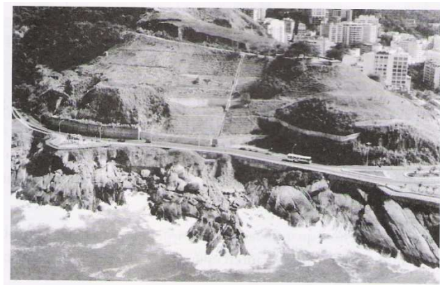
Figura 6.3 – Sistema de drenagem superficial (GEORIO, 2000b)
