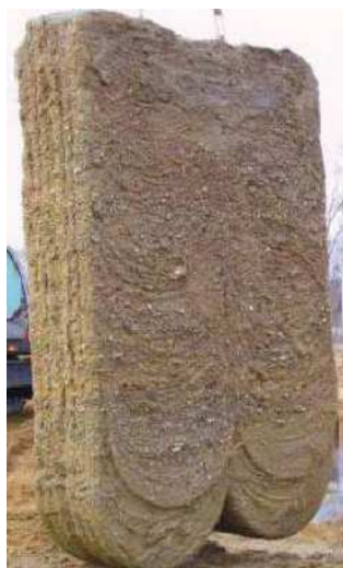
Figura 6.35 – Aspecto final de um painel de solo tratado com CSM (www.remtech2008.com – Sousa, 2009)
