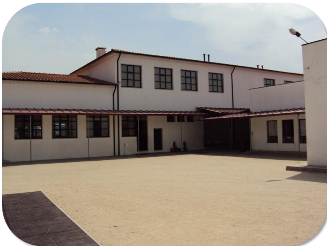
Fig.20. Escola Primária de Bouça – Medelo depois da Reabilitação.
