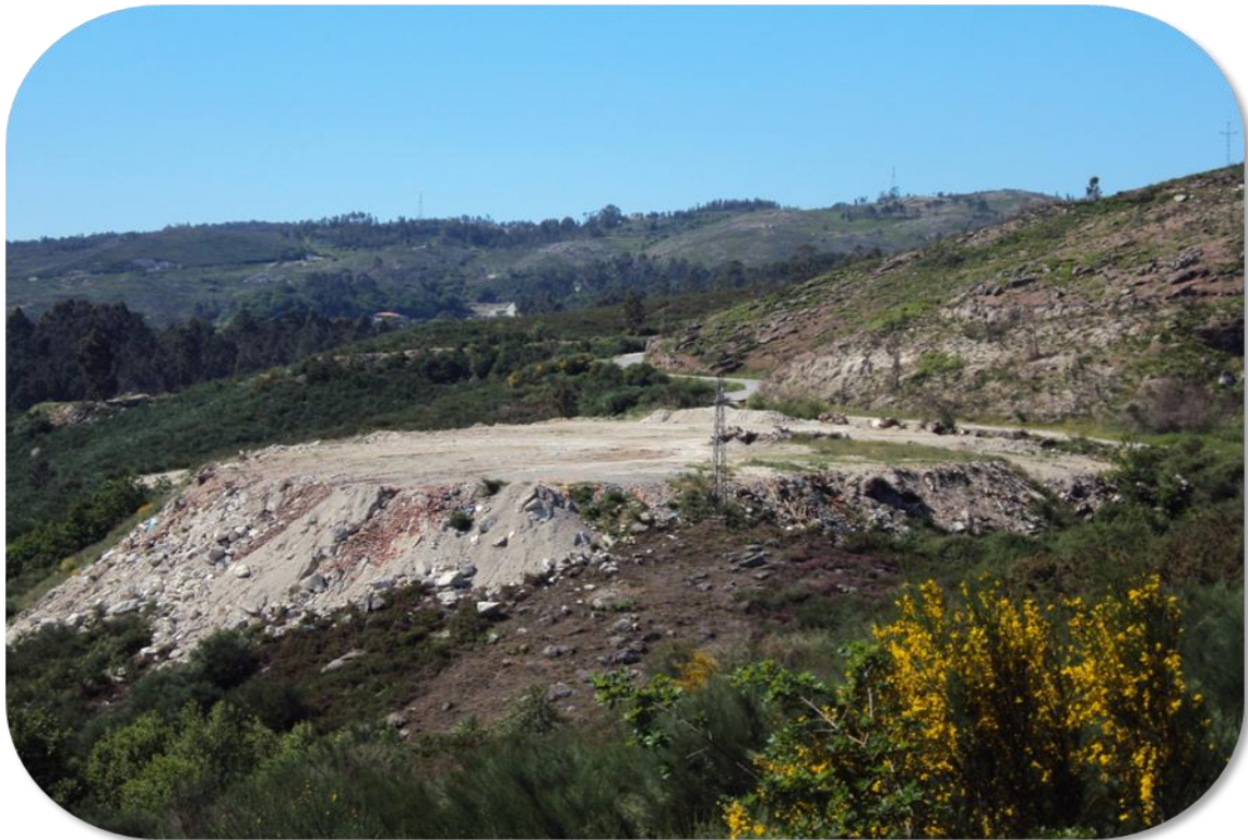
Fig.13. Plataforma de Queimadela após a limpeza dos RCD.
