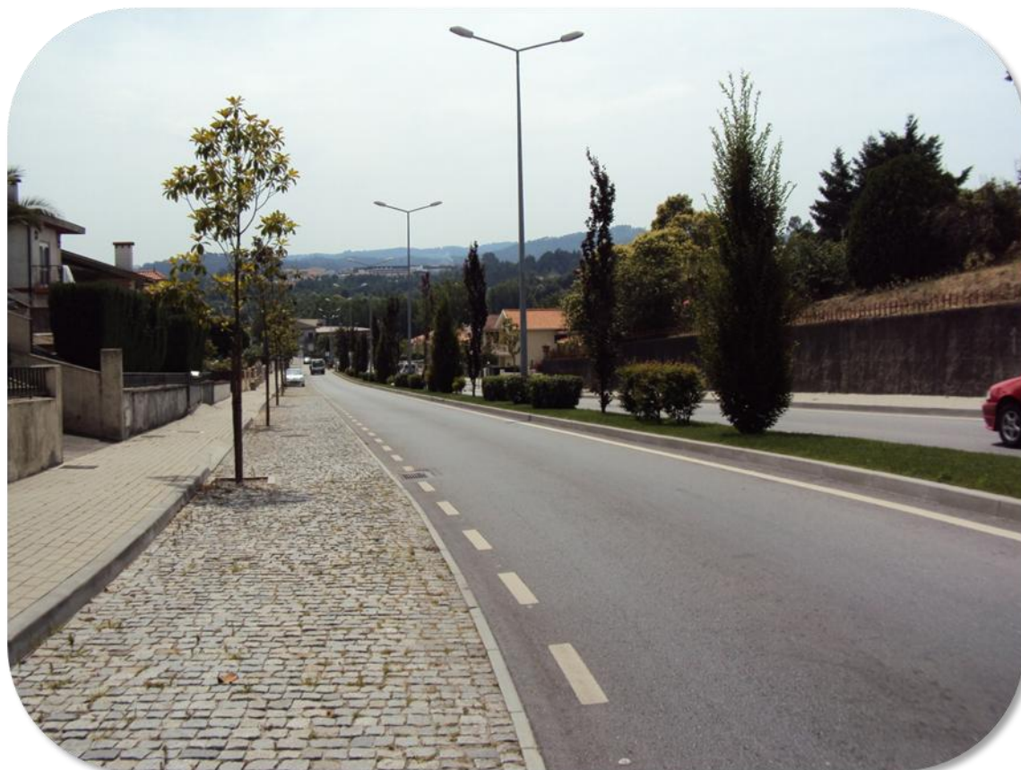
Fig.21. Parte da E.N206 entre a Ponte Nova e a Via Circular depois da Reabilitação.
