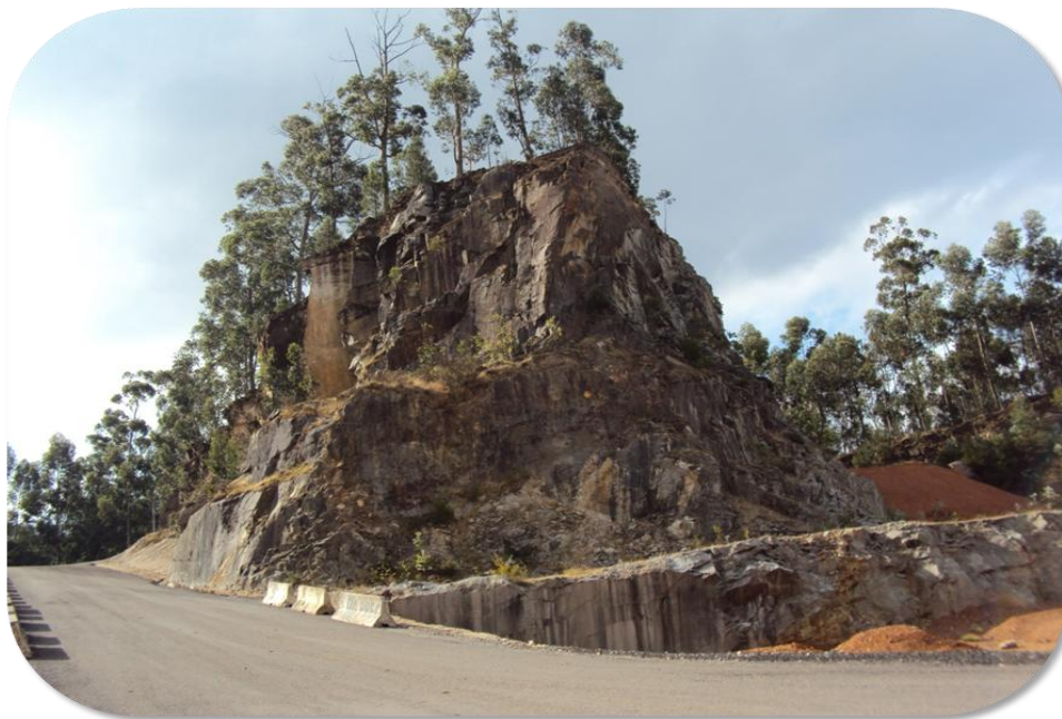
Fig.16. Rampa de acesso à base da cratera.
