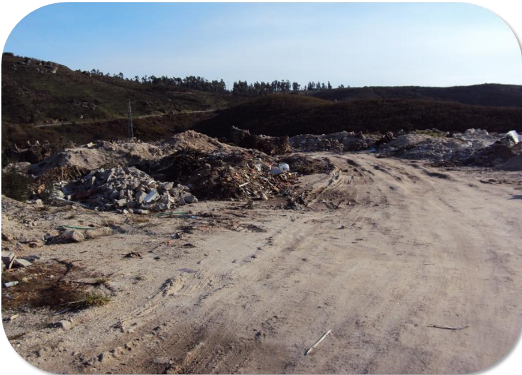
Fig.11. Plataforma em Queimadela antes da limpeza feita pela CMF.
