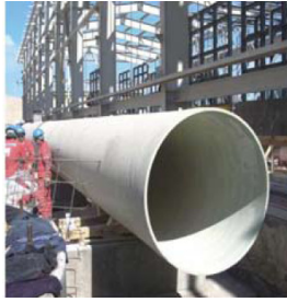
Figura 18 Tubagem de grandes dimensões em GFRP produzida por enrolamento filamental
