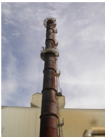
Figura 24 – Chaminé do forno AV5
