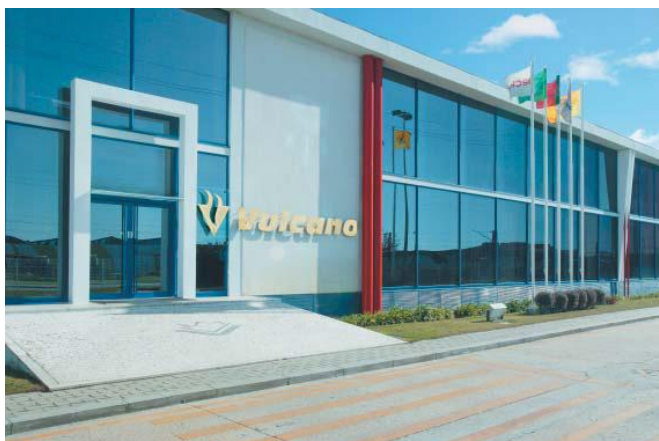
Figura 1 – Edifício da Bosch Termotecnologia SA
