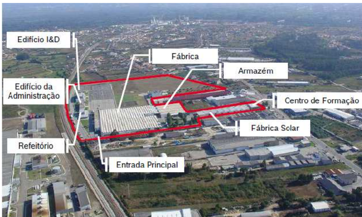
Fig. 1 - Instalações da BOSCH Termotecnologia em Aveiro, Portugal.
