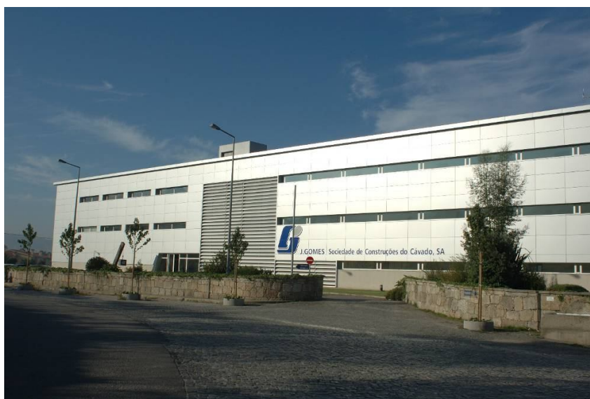
Fig. 2 – Instalações da J.Gomes – Sociedade de Construções, SA
