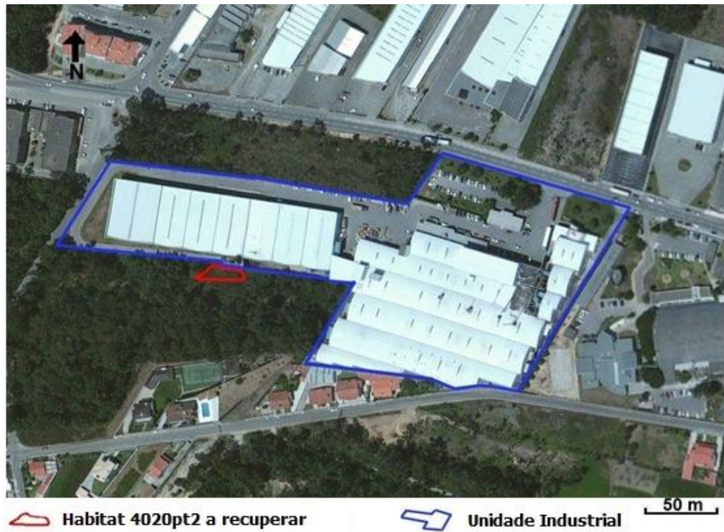
Figura 7: Zona de habitat 4020pt2 afetado
