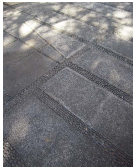
24. Materiais – calhau rolado do mar e placagem de betão
