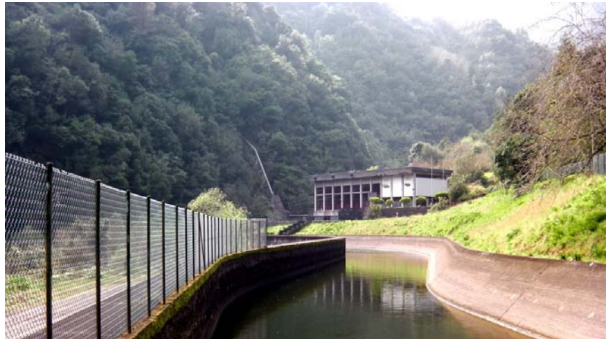
33. Central Hidroelétrica da Fajã da Nogueira
