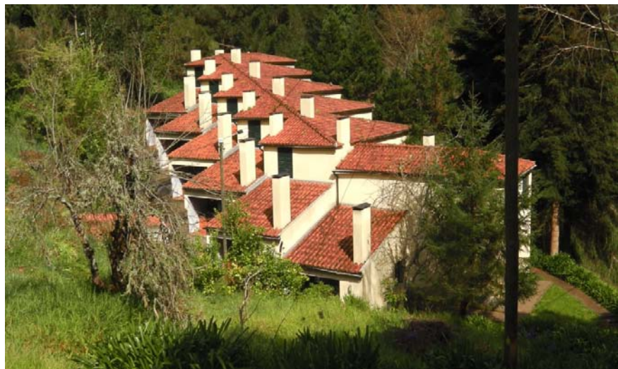
34. Habitações para operários do Conjunto Hidroelétrico da Fajã da Nogueira
