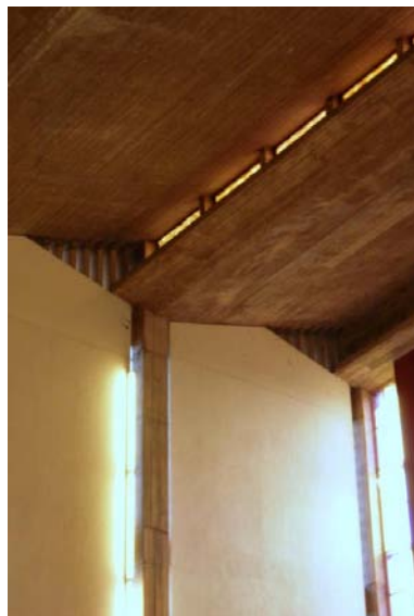
11. Vista interior da cobertura
