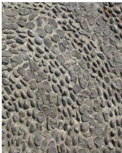
23. Materiais - pavimento em calhau rolado do mar
