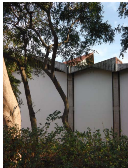
12. Vista exterior da cobertura
