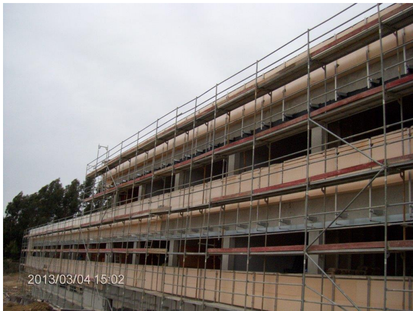
Figura 16: Fase de Construção do Parque Tecnológico de Ourivesaria e Negócios de Gondomar
