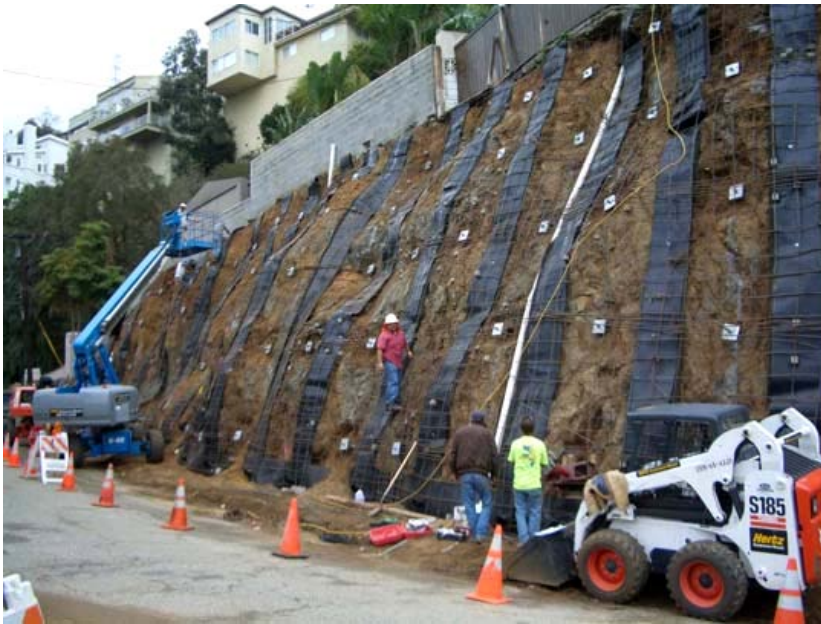
Figura 3- Aplicação de pregagens num talude. Fonte: (www.engenhariacivil.com).
