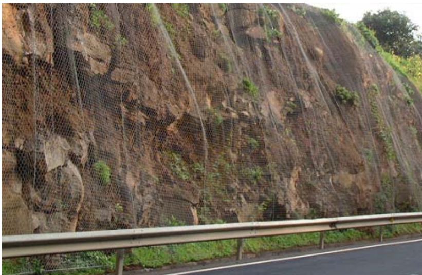
Figura 4- Talude estabilizado com redes electro soldadas. Fonte: (www.enrico-piolanti.pt)
