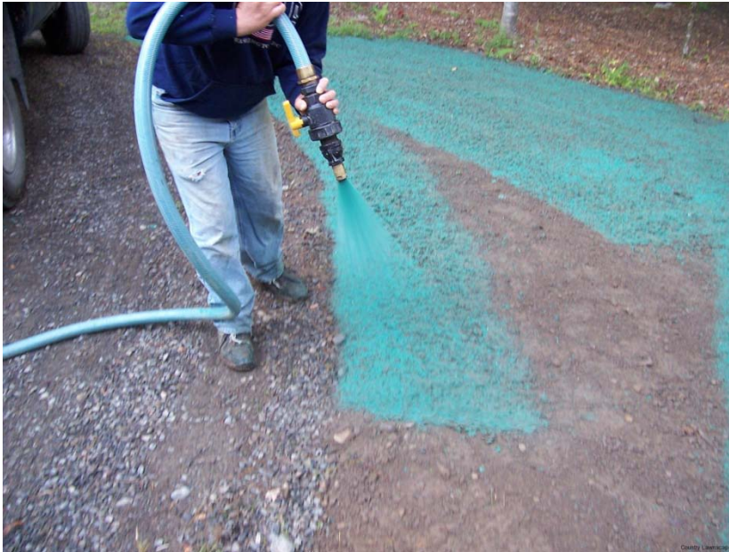
Figura 5 – Aplicação de hidrossementeira. Fonte: ( http://www.countrylawnsapes.com/ ).
