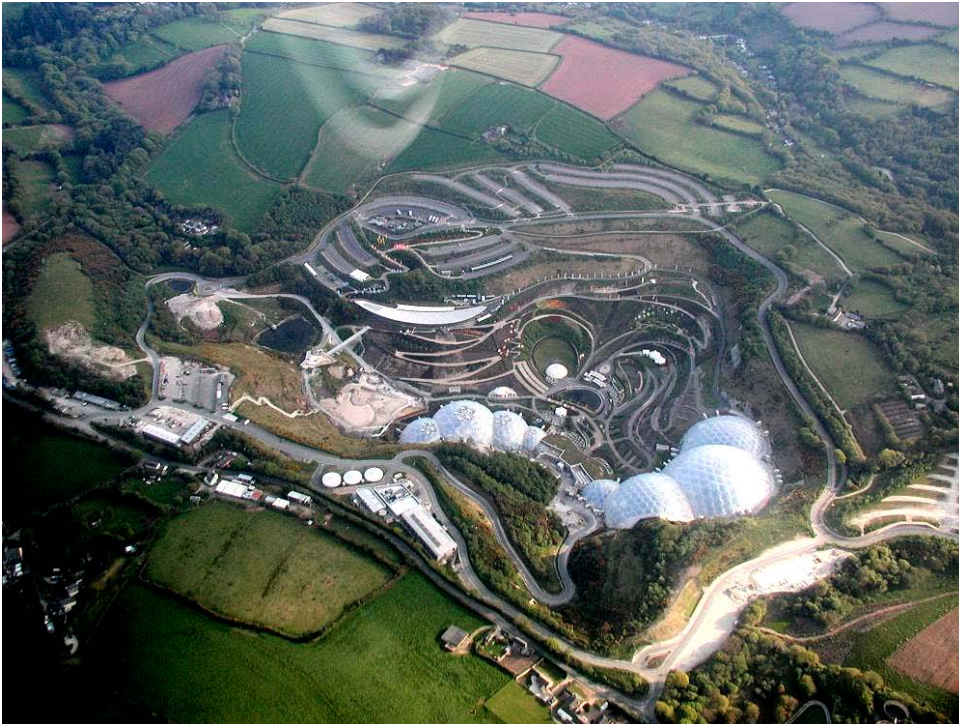
Fig.7 - Vista aérea do Projeto Éden. Fonte: ( http://www.eden-project.co.uk/images/3000ft-view-eden.jpg ).
