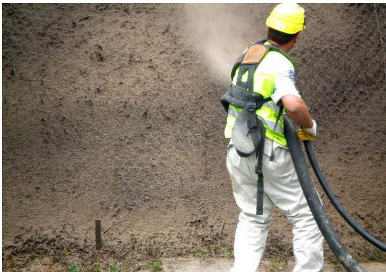
Figura 2 - Projeção de cimento. Fonte: ( http://www.agrariaverde.pt )
