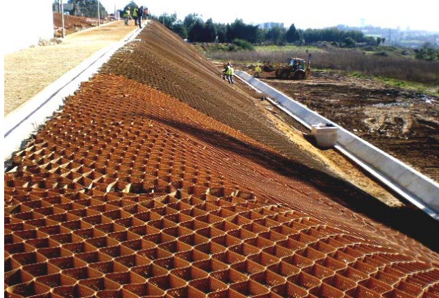
Figura 9 e 10- Aplicação da técnica de grade viva. Fonte: ( http://www.agrariaverde.pt )
