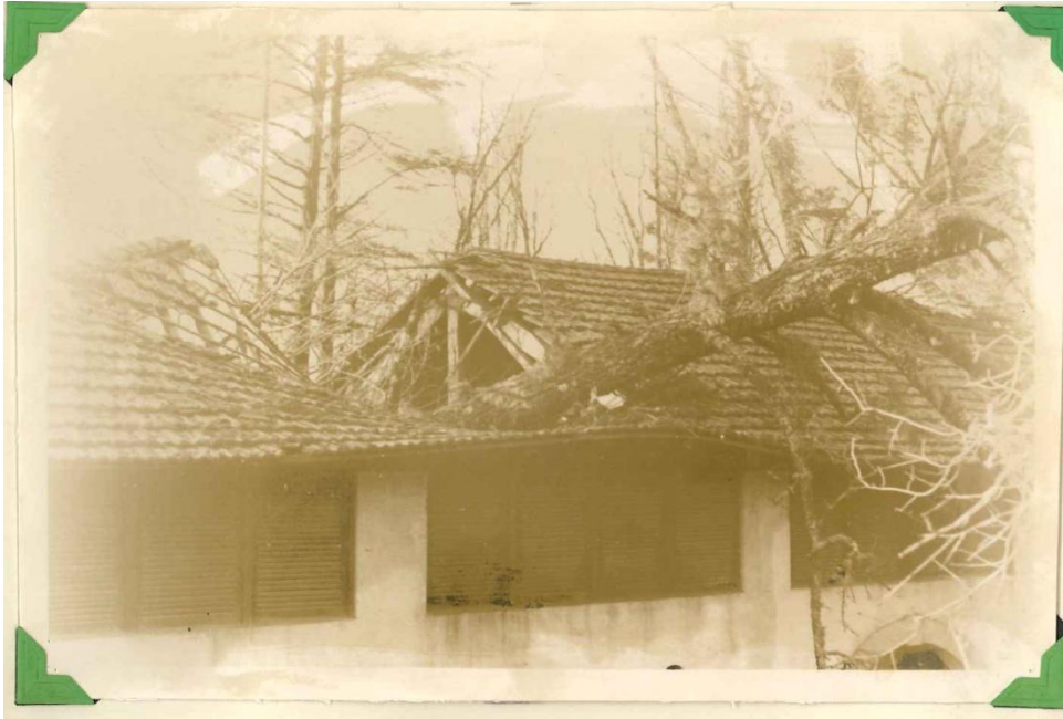
Fig 14 – Destruição de armazém de madeiras, 1941 (fonte: DGSFA)
