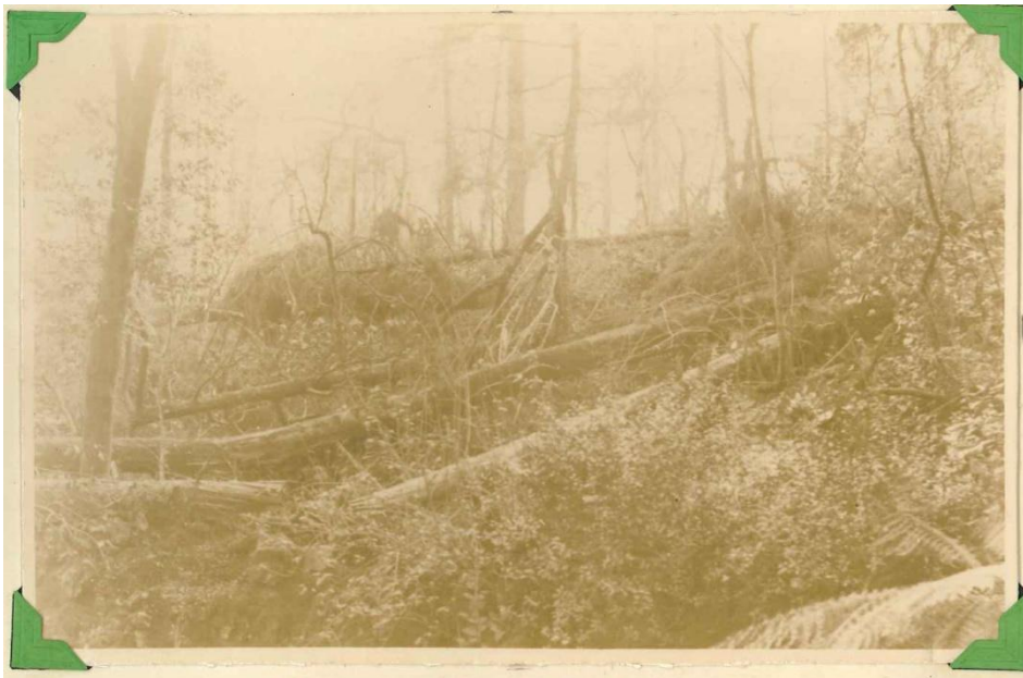
Fig 13 – Queda de árvores na Cascata, 1941 (fonte: DGSFA).
