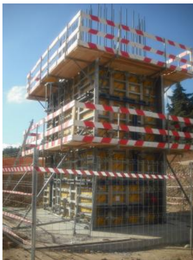
Fig. 14 - Plataformas de trabalho de uma cofragem [21]
