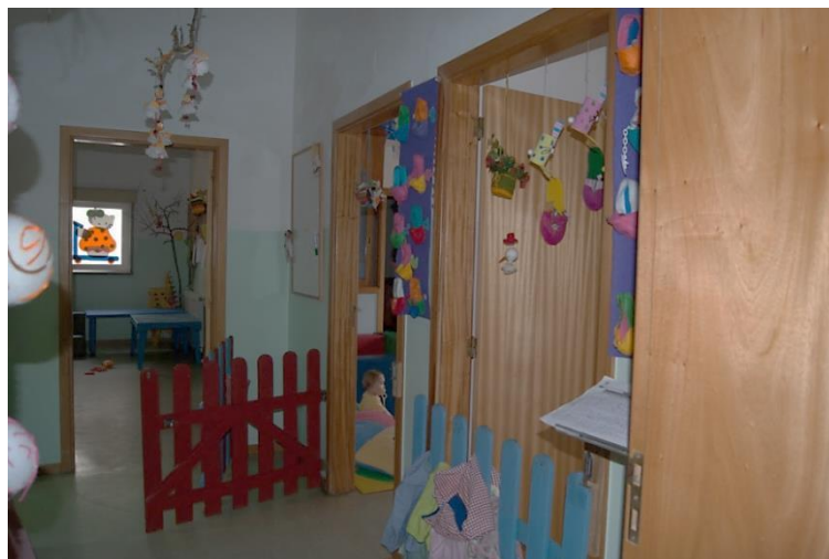
Figura 8 -Três salas da valência Creche
