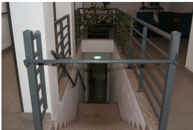
Figura 7 - Escadaria de acesso do piso 1 para o piso 0
