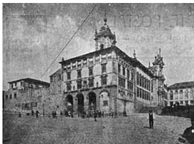
Fig. 5 – Convento de S. Bento de Avé Maria antes de começarem as demolições.
