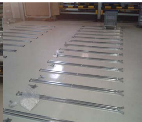
Figura 28 Colocação das guias na secção
