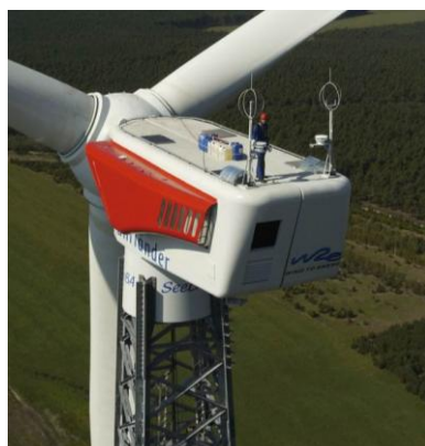
Figura 6.2 – Pormenor de entrada do aerogerador na torre [32]
