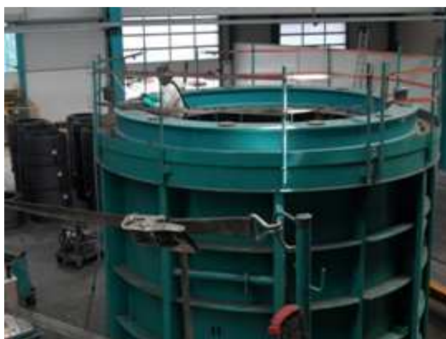
Figura 3.40 – Injeção da Resina Epoxy
