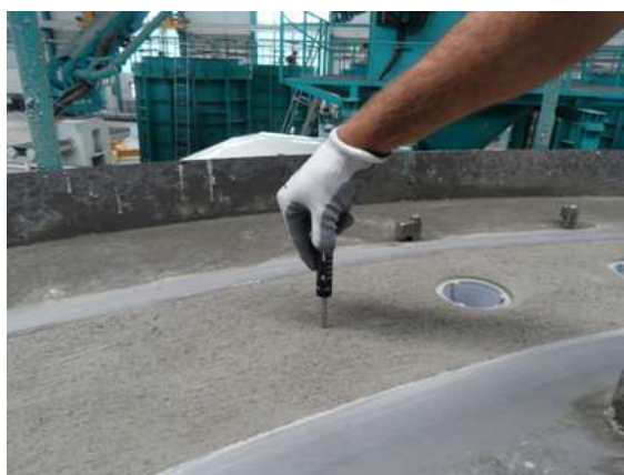
Figura 3.37 – Base pronta para receber a resina
