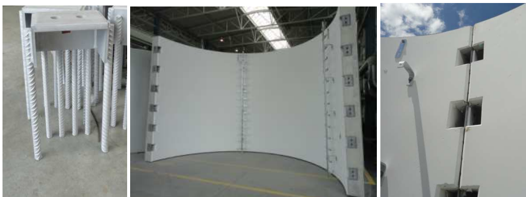
Figura 3.7 – Junta com dispositivos de fixação
