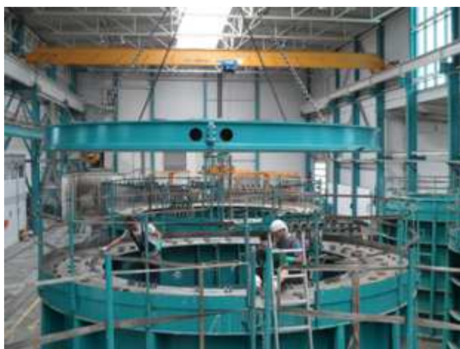
Figura 3.39 – Colocação do molde de injeção da resina
