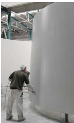
Figura 3.47 – Aplicação da tinta com pulverizador pneumático
