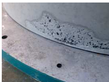
Figura 3.19 – Ninho de brita por ausência de vedante na base do molde
