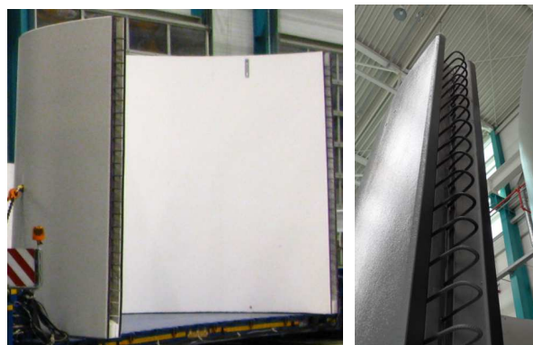
Figura 3.6 – Junta em forma de caixa de conexão
