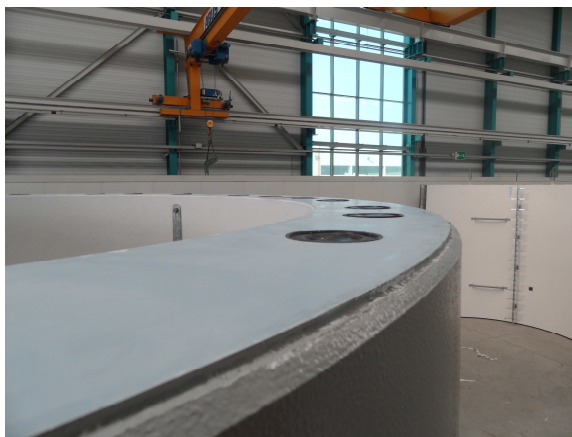
Figura 3.8 - Aspecto final da junta em epoxy no topo do segmento
