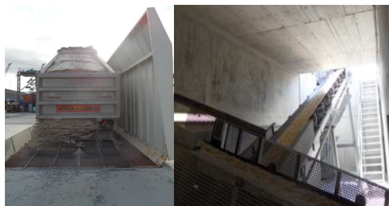
Figura 3.20 – Receção dos agregados
