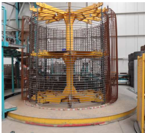
Figura 3.13 – Exemplo da colocação dos estribos sobre a armadura interior
