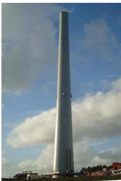
Figura 3.9 – Torre após montagem dos segmentos em betão
