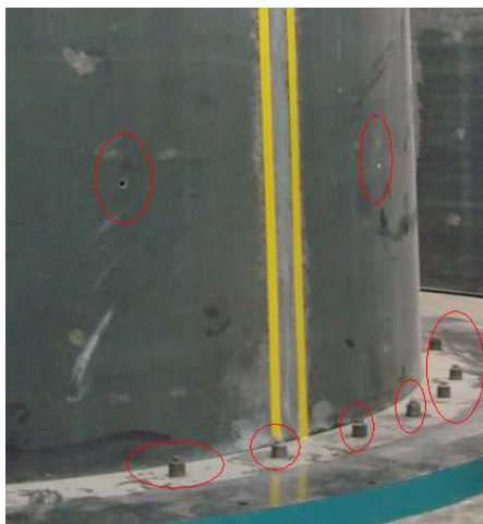
Figura 3.17 – Molde após correcta colocação dos dispositivos de fixação
