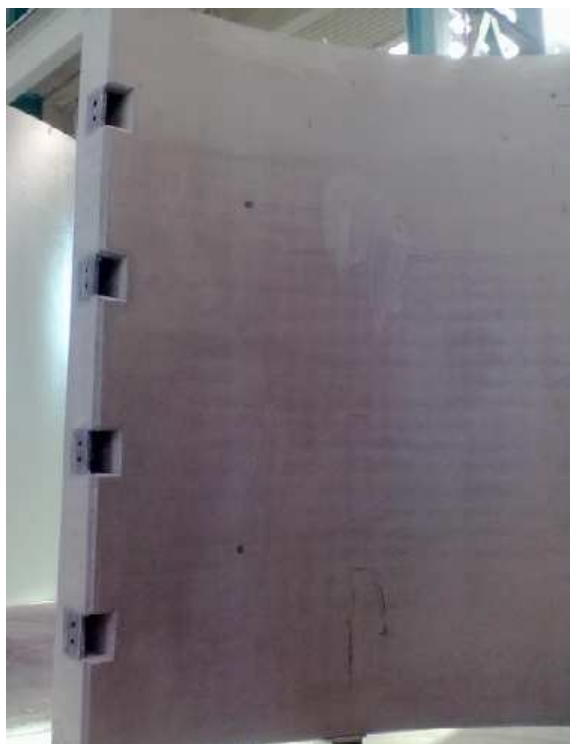
Figura 4.12 – Segmento betonado com C45/55 auto-compactavel
