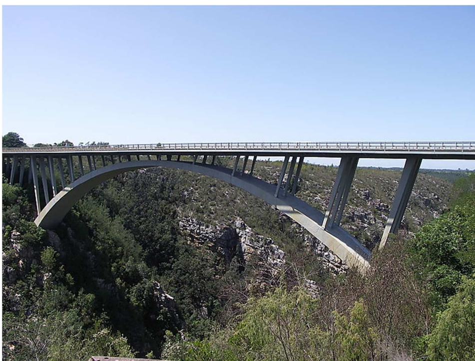
Figura 2.8 – Paul Sauer Bridge em Eastern Cape, África do Sul [35]
