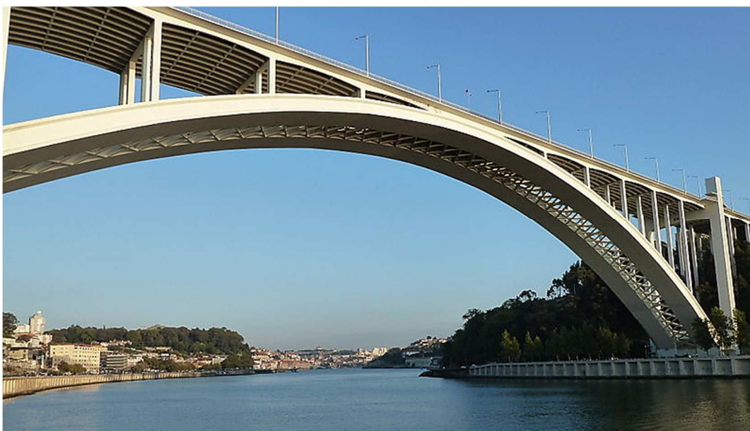
Figura 2.7 – Ponte da Arrábida no Porto, Portugal (Jiménez, 2010) [34]
