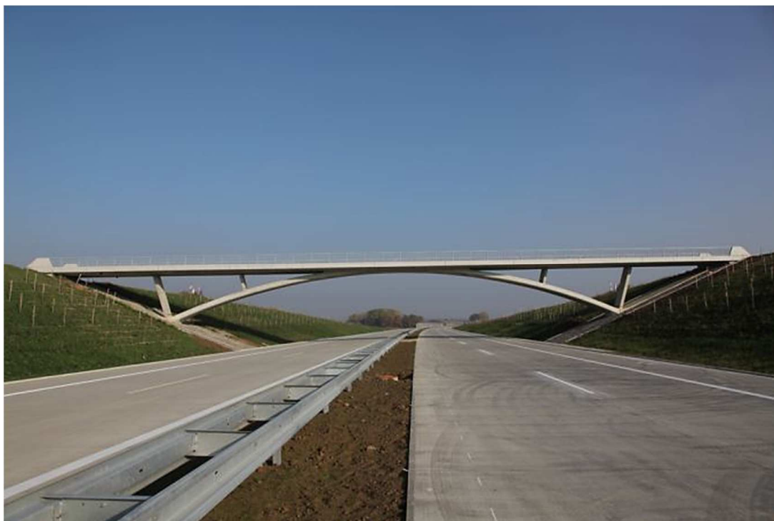
Figura 2.12 – Viaduto sobre a autoestrada D47, República Checa (Strasky, 2009) [39]
