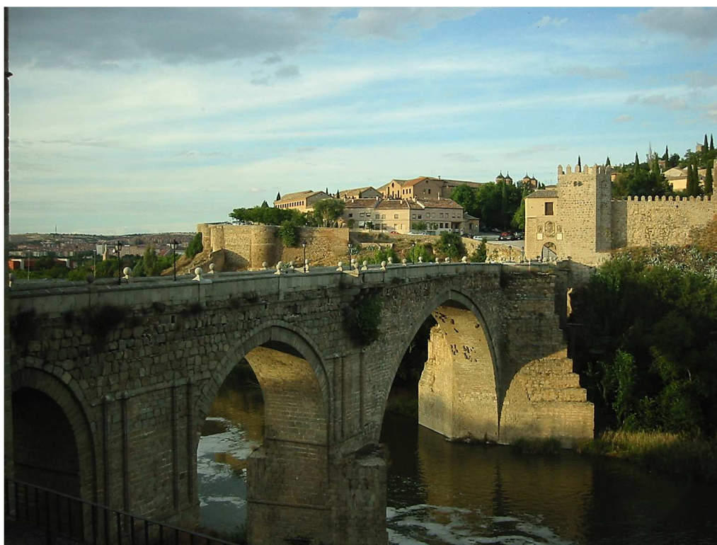
Figura 2.2 – Puente de San Martin em Toledo, Espanha (Simoff, 2002) [30]
