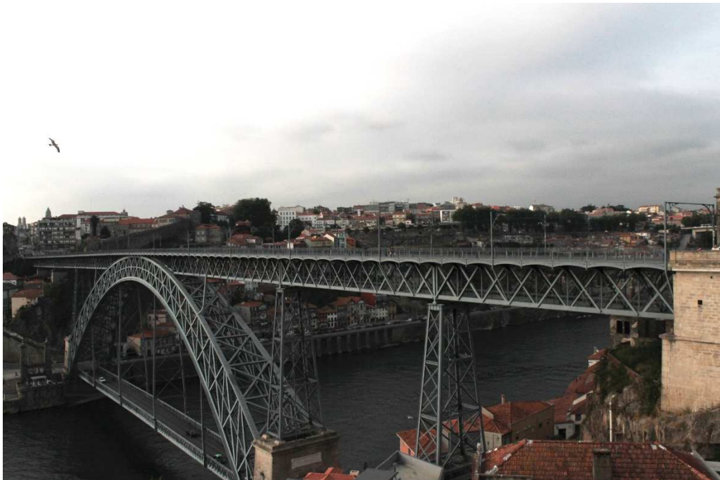
Figura 2.6 – Ponte Luís I no Porto, Portugal (Falcão, 2013)
