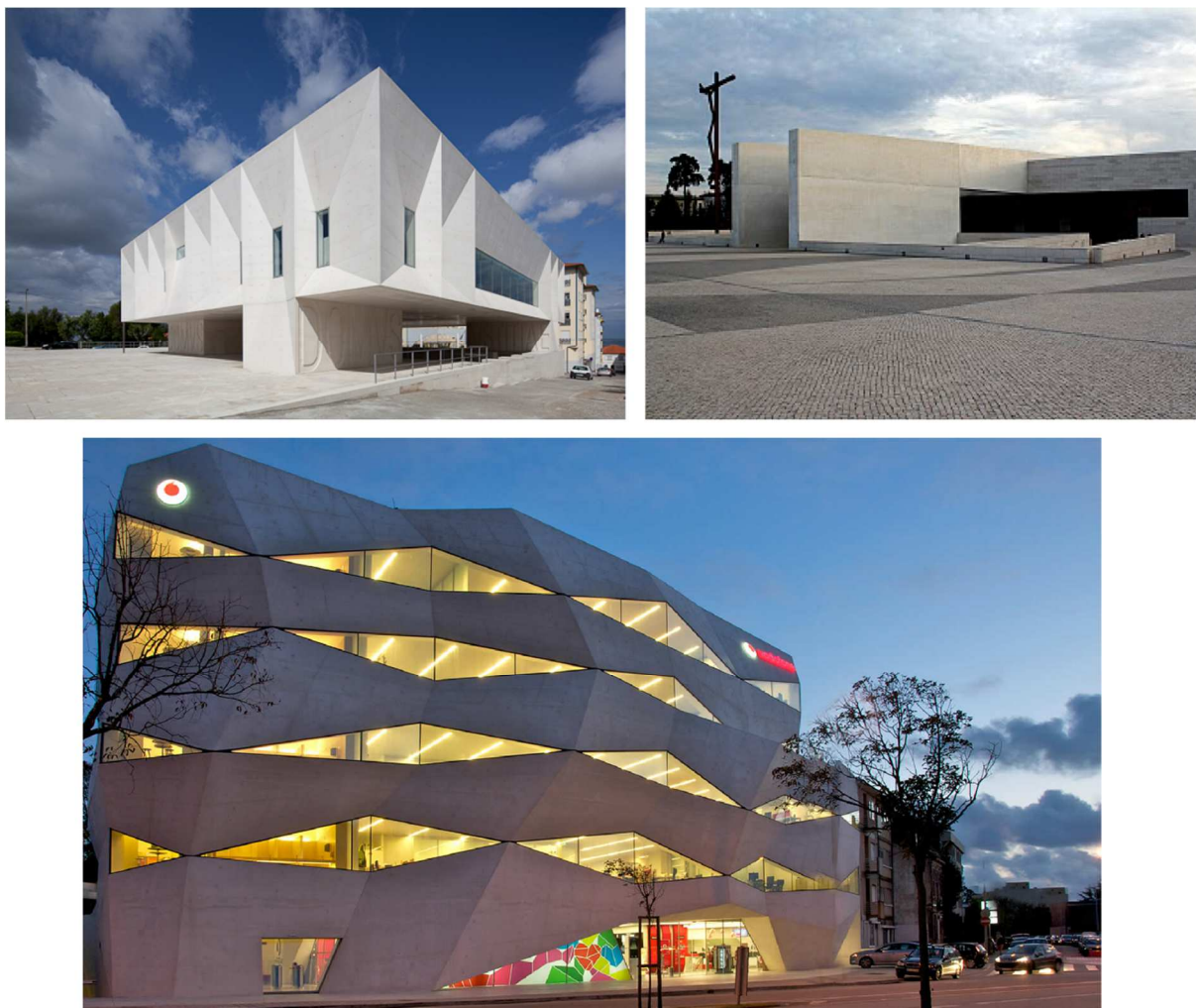
Figura 4.2 – Palácio da Justiça de Gouveia (canto superior esquerdo); Igreja da Santíssima Trindade em Fátima (canto superior direito); Edifício da Vodafone no Porto (em baixo) [40] [41] [42]
