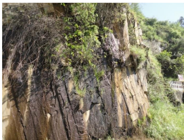
Figura 68 – Presença de água num maciço rochoso
