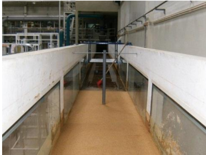
Fig. 3.1 – Canal visto de jusante
