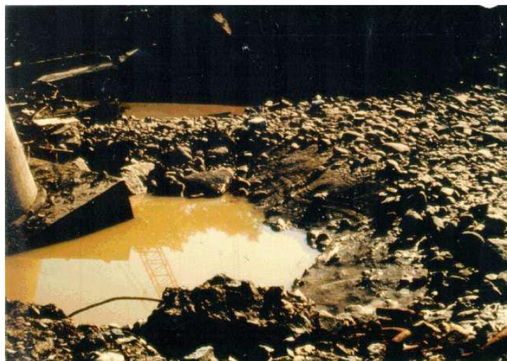
Fig. 1.1 – Cavidade de erosão que originou o acidente em Schoharie Creek , EUA [1]
