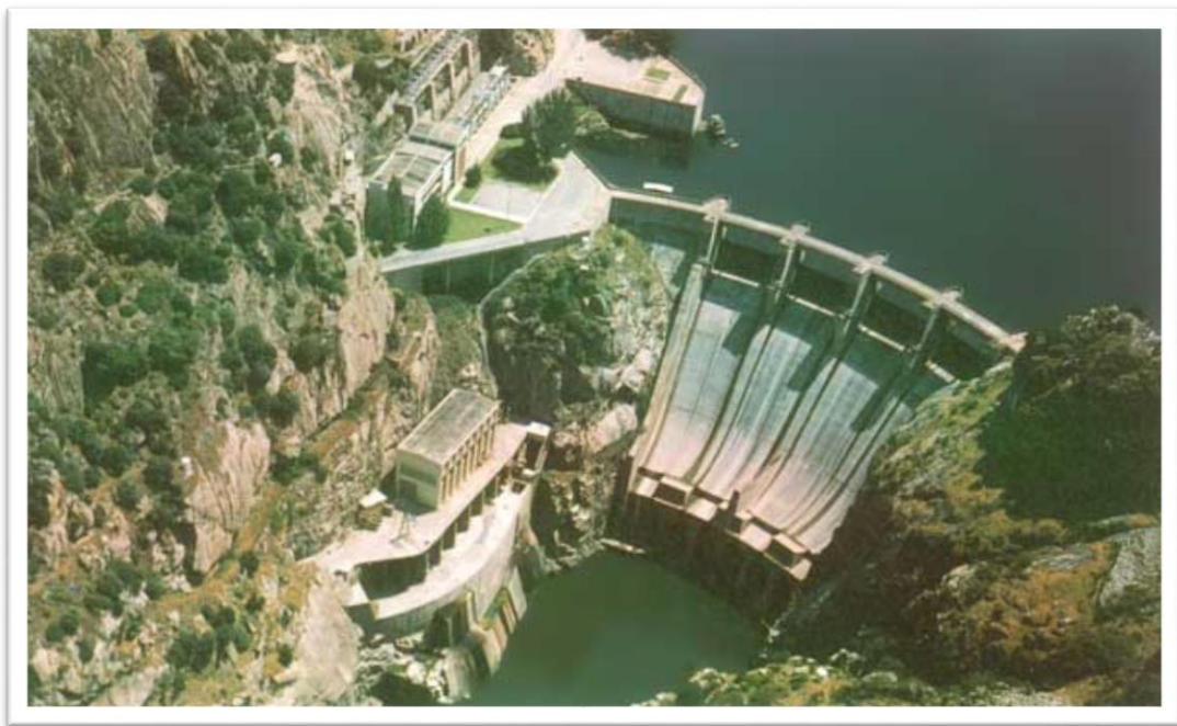
Figura 8 - Barragem de Picote
