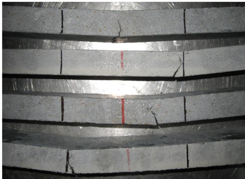
Fig.4.31. – Fendilhação entre os pontos de aplicação de carga.
