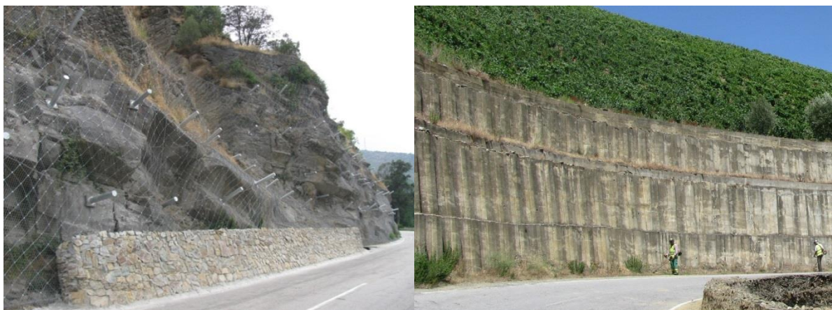
Fig. 5.1. – Exemplos de obras de estabilização realizadas na RDD
