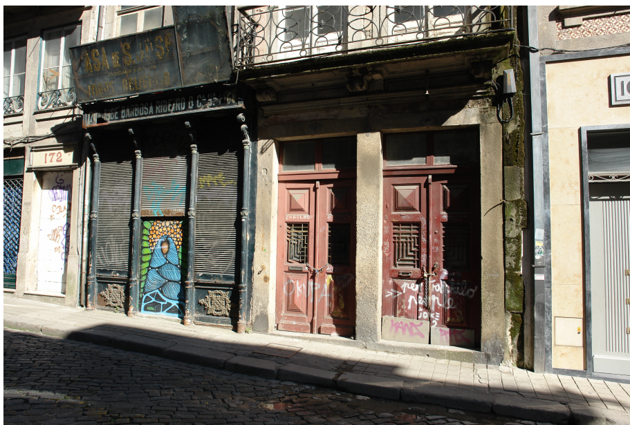
Fig. 19 – À esquerda, com a porta emparedada, a parcela 23, e à direita, com a porta do acesso comercial e a de acesso aos pisos superiores, a parcela 24
