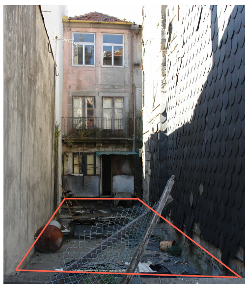
Fig. 29 – Local de instalação dos serviços de cozinha e sala de refeições
