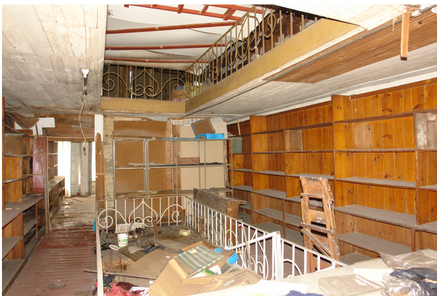
Fig. 20 – O interior da parcela 8 em madeira e com as aberturas para permitir a passagem de luz a partir da cobertura
