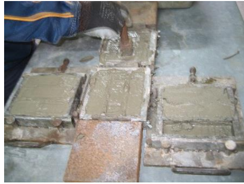
Figura 3.14 – Colocação da argamassa nos moldes
