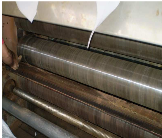
Figura 14 – Limpeza dos cilindros
