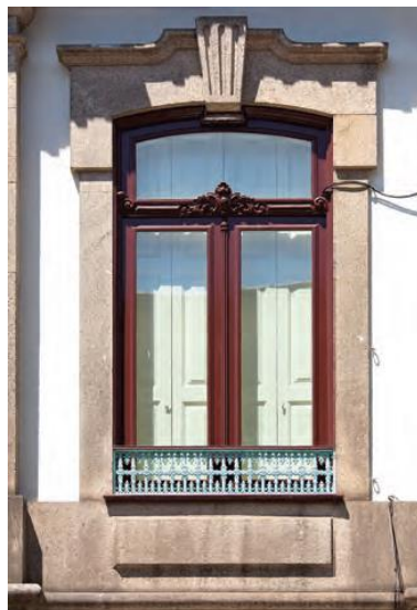
Figura 12 - Caixilharia de madeira associada a vidro simples, com proteção interior [5]
