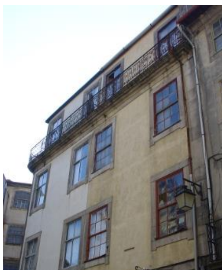
Figura 9 - Paredes de fachada em alvenaria de pedra [21]
