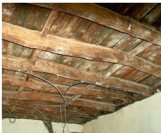
Figura 11 - Laje de teto em madeira [23]
