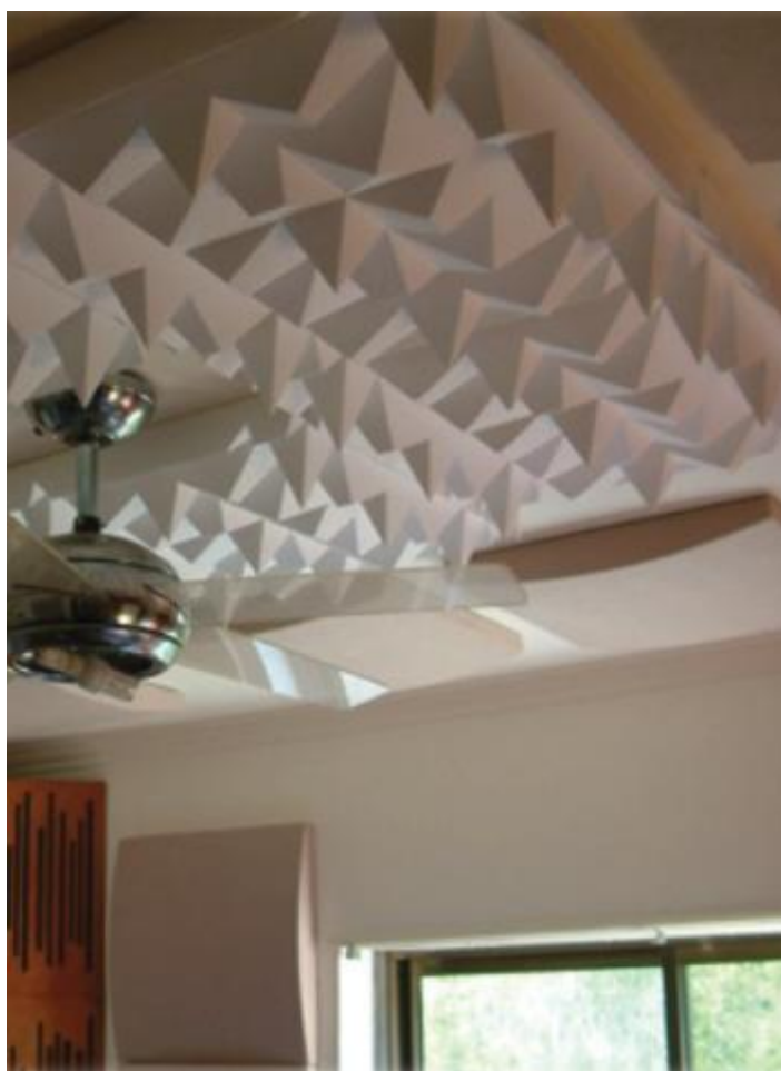
Fig. 3.21 – Aplicação do Super Fuser Spyke 2 - Portugal. [25]
