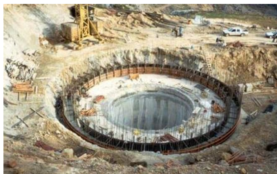
Figura 5.2 – Chaminé de equilíbrio em construção [4]
