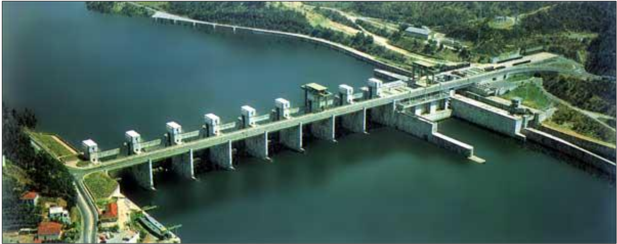
Figura 2.8 – Aproveitamento Hidroelétrico de Crestuma-Lever com eclusa de navegação junto à margem direita [1]
