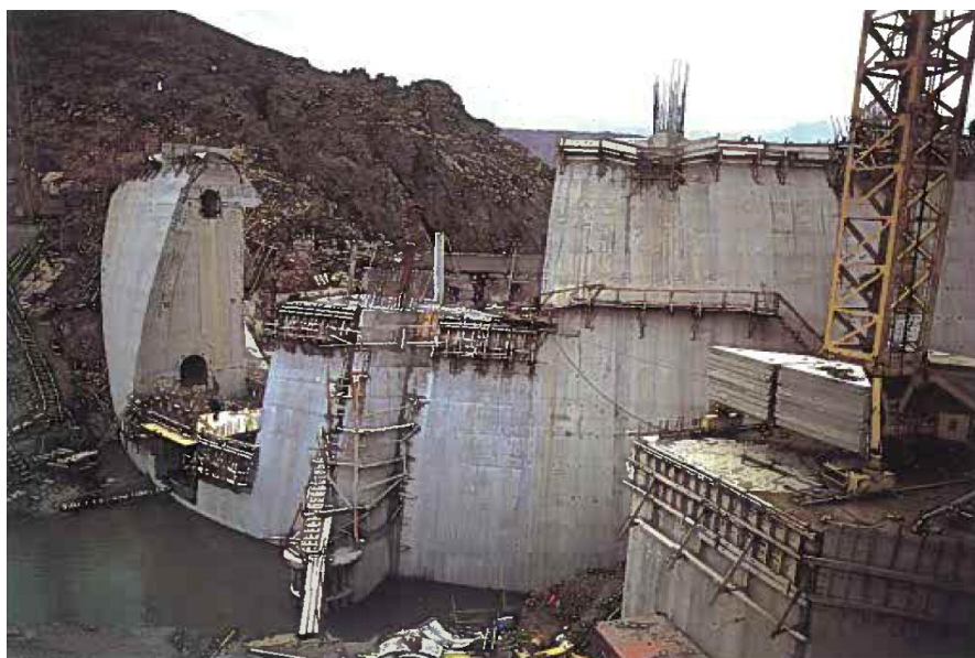
Figura 4.1 – Construção da barragem de betão do Aproveitamento do Caldeirão (EDP, 1992)
