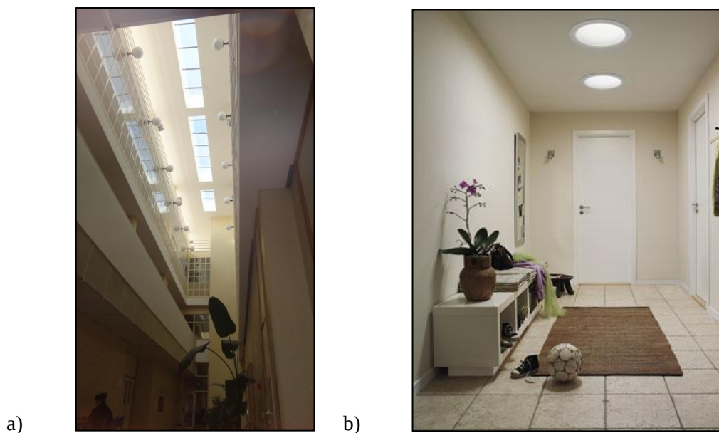
Fig. 5 – a) Claraboias no departamento de biologia da FCUP, b) Hall de entrada com candeeiros solares [5]
