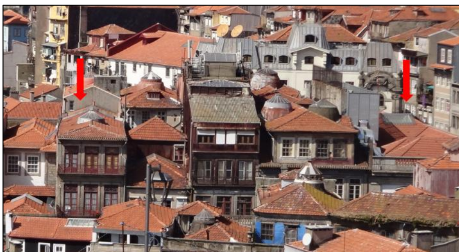
Fig. 6 – Ribeira do Porto, Claraboias em edifícios antigos
