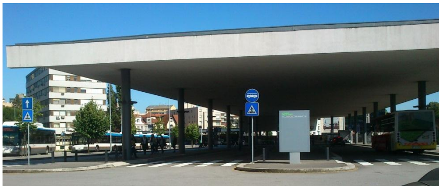
Fig. 28 – Proteção das paragens de autocarros na Interface da Casa da Música
