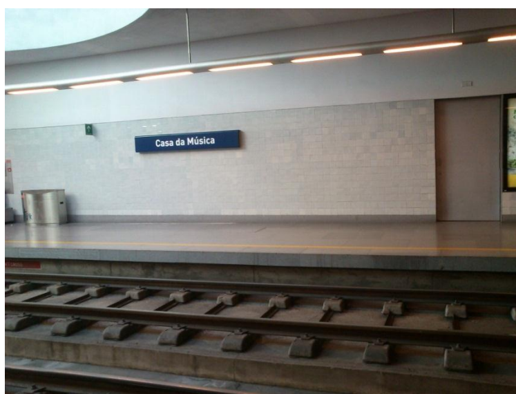
Fig. 13 – Iluminação segundo a marcação amarela de segurança
