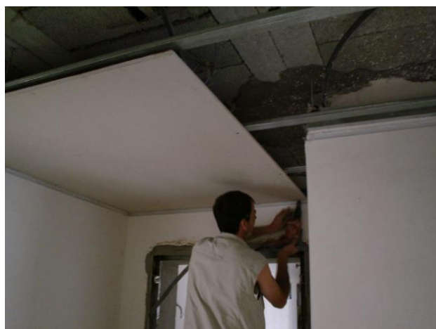
Fig. 2.10 – Aplicação de teto falso [23]
