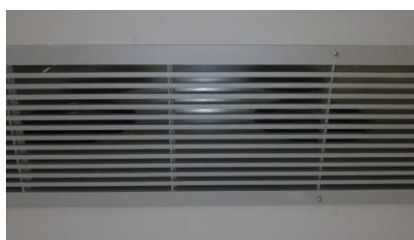
Fig. 6.30 – Grelha de saída de ar
