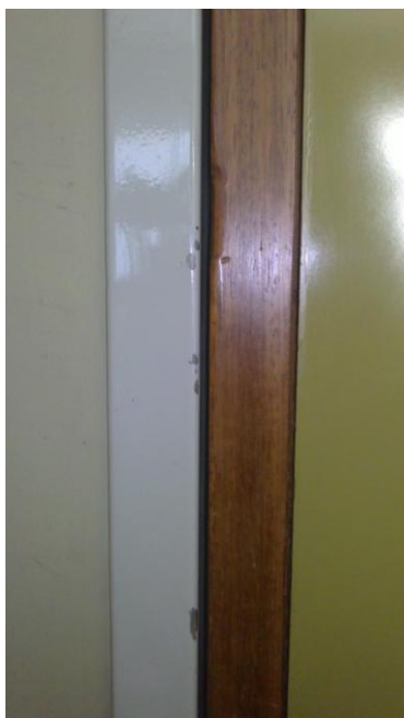
Fig. 7.1 – Frincha entre a porta e o aro que a envolve
