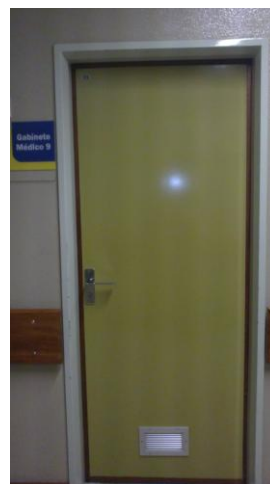
Fig. 6.15 e 6.16 – Elemento envidraçado acima da padieira da porta do local recetor e porta com grelha de ventilação no local emissor
