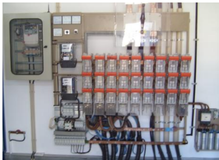
Figura 2.8 - Quadro Geral Baixa Tensão do posto de transformação
