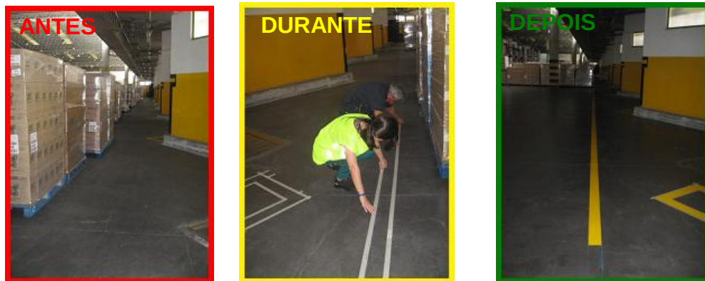
Figura 20 - Antes e Depois - Linha limitadora de cais
