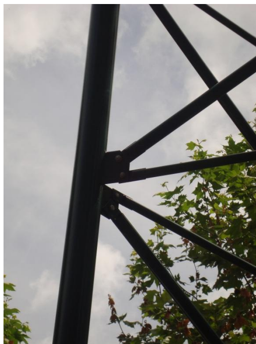
Figura 6.4 - Pormenor de ligação aparafusada
