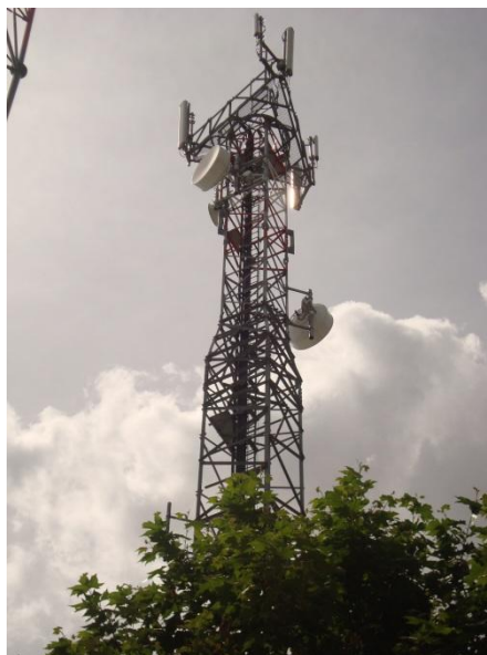
Figura 1.2 - Torre de telecomunicações reticulada quadrangular
