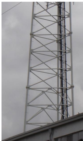
Figura 6.7 - Exemplo de ligação com recurso a flange
