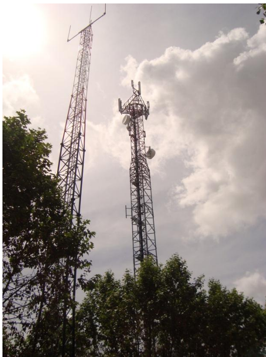
Figura 1.1 - Torres de telecomunicações
