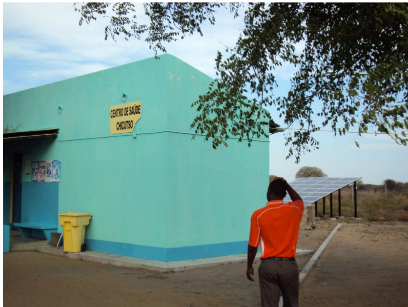
Figura 5.1 - Aldeia Moçambicana, módulos fotovoltaicos que alimentam um centro de saúde
