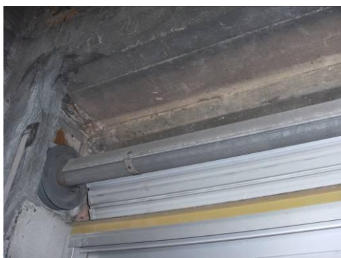
Figura 4.11- caixa-de-estore e grelha de ventilação
