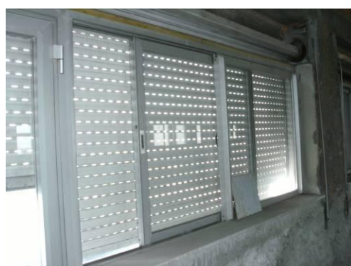
Figuras 4.13 - Configuração de soleira e réguas de PVC
