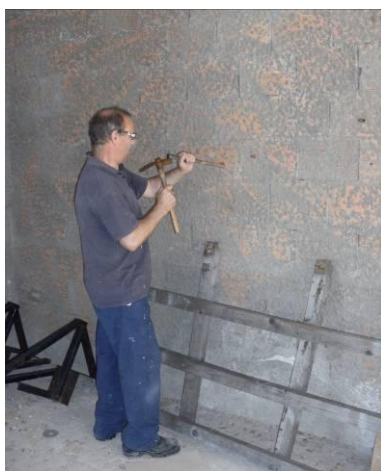
Figura 4.6 - Realização de sondagem
