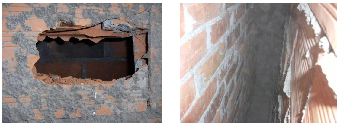
Figuras 4.8 - Sondagem realizada
