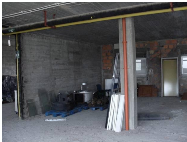
Figura 4.5 - Paredes, pilares e laje em betão armado
