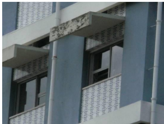
Figura 4.15- Varandas e palas de sombreamento
