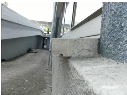
Figuras 4.13 - Configuração de soleira e réguas de PVC
