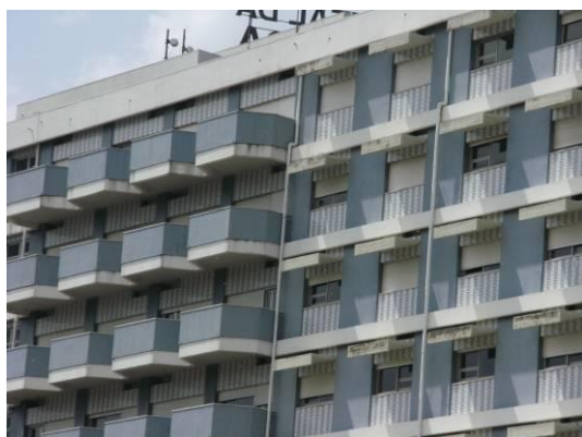
Figura 4.15- Varandas e palas de sombreamento
