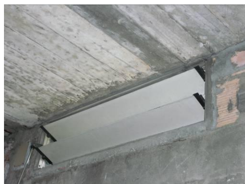
Figura 4.11- caixa-de-estore e grelha de ventilação
