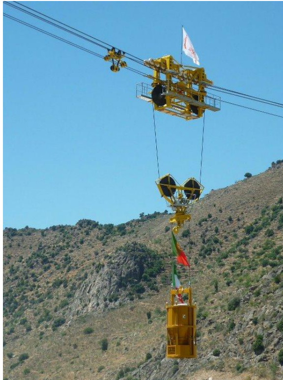
Fig. 1.1 – Blondin na barragem do Baixo Sabor (Agudio)
