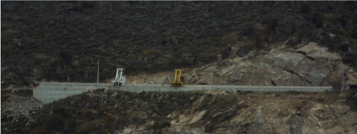
Fig. 2.14 – Viga da margem esquerda do Baixo Sabor
