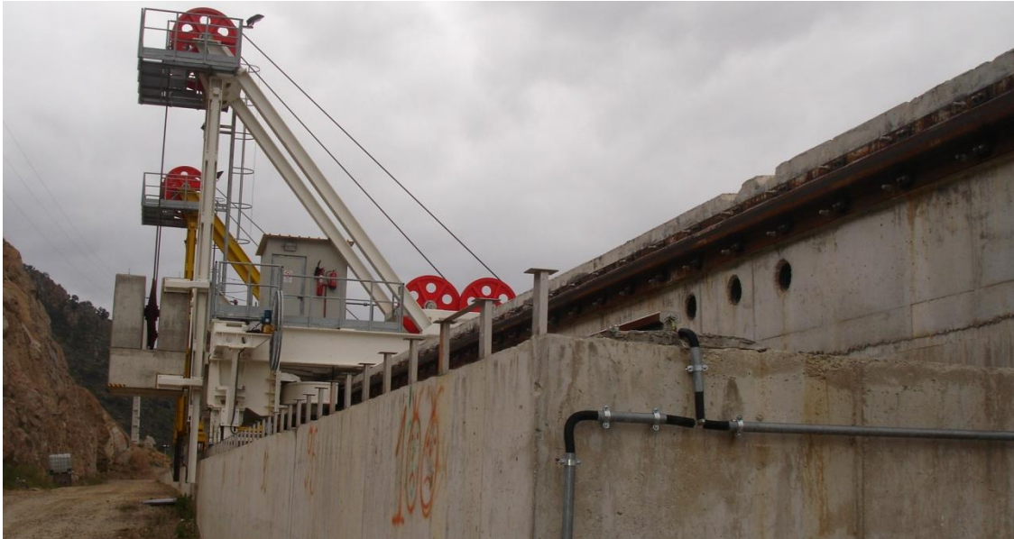
Fig. 2.16 - Carro de retorno da margem esquerda na barragem do Baixo Sabor
