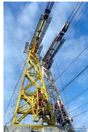
Fig. 2.3 - Torre fixa do blondin radial
