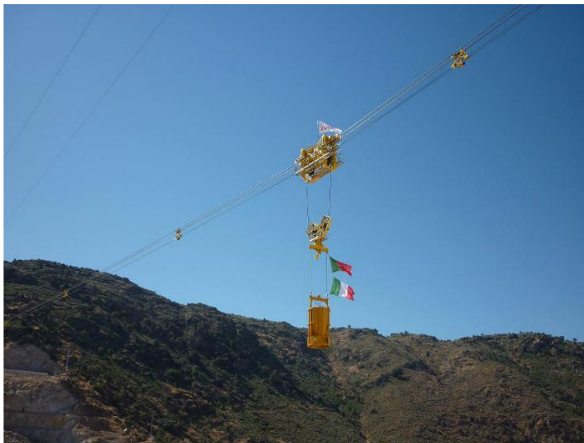
Fig. 2.11 - Balde e gancho do blondin em Torre de Moncorvo-Baixo Sabor (AGUDIO, 2012)
