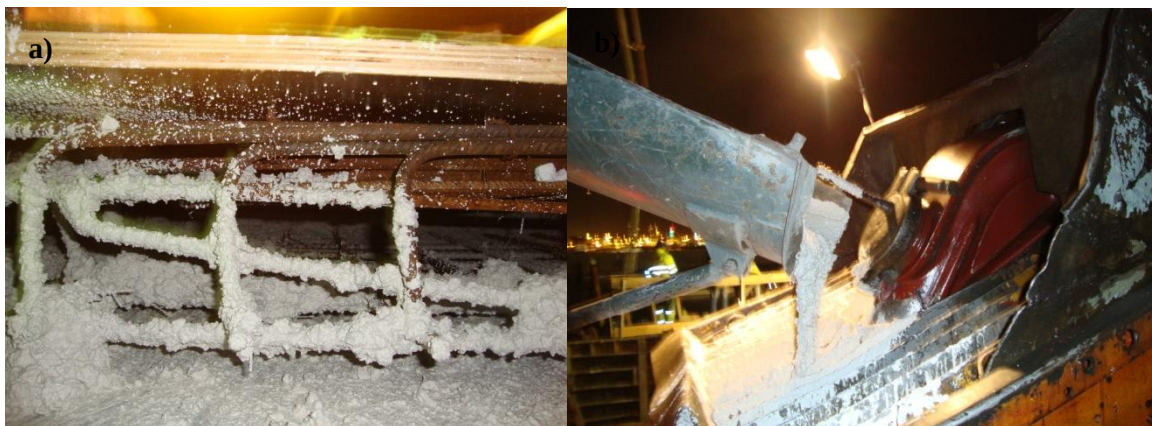
Fig. 3.9. – (a) e (b) pormenores do escoamento da segunda amassadura.
