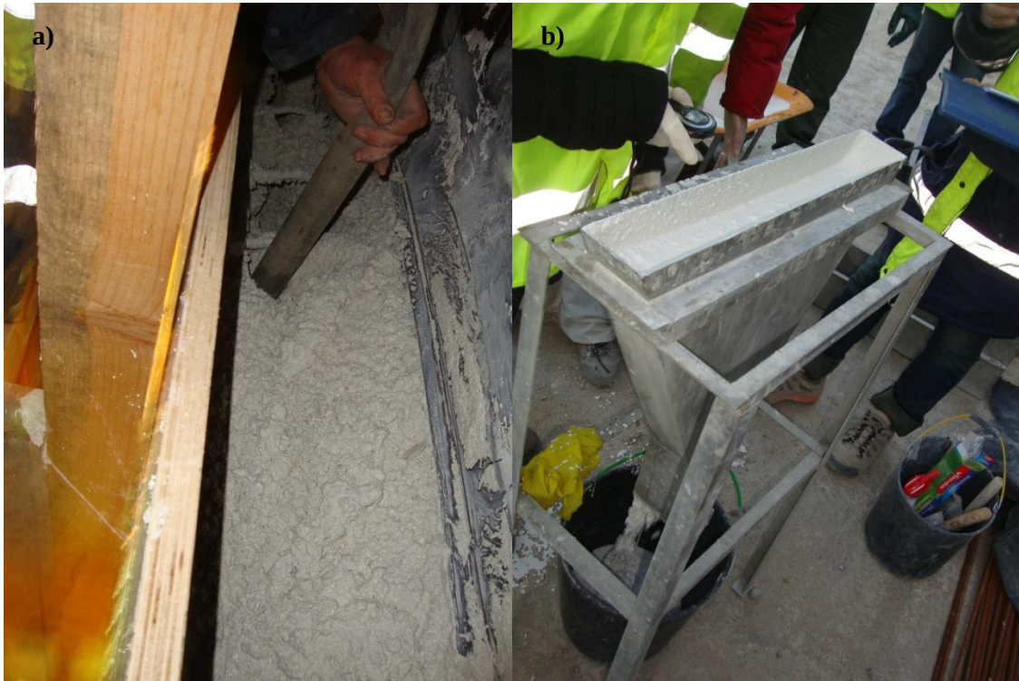
Fig. 3.8. – Segunda amassadura: (a) Colocação do betão com vibração; (b) ensaio de funil V.
