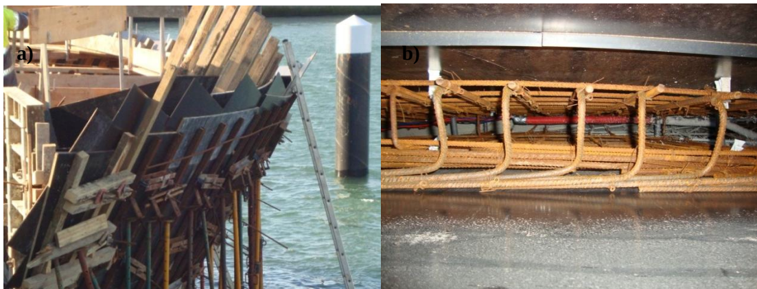
Fig. 3.5. – Estrutura a betonar: (a) parede de forma complexa; (b) densidade de armadura na parede
