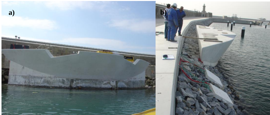
Fig. 3.6. - (a) e (b) Aspecto final do Porto de Recreio onde foi aplicado o BAC branco (parede curva do elemento)
