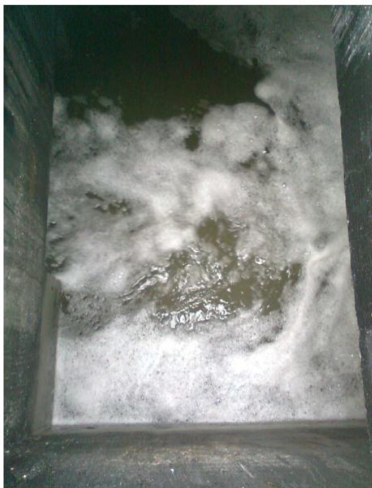
Figura 4.9. – Presencia de tensioactivos en la elevación inicial de la ETAR.
